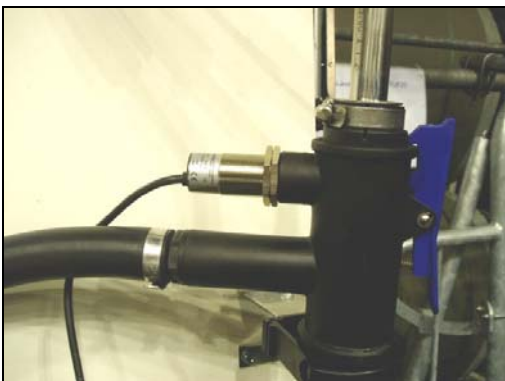
DeLavalin pesuturvakytkimen anturi sijaitsee maidonpumppausputken pesutelineessä.
