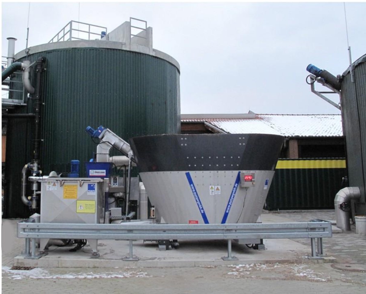
Kuva 25. Tuoreena korjatun ruokohelpisilpun käyttö lisäsyötteenä tehostaa biokaasun tuotantoa lietelannasta (Kwokori ym. 2026). Kuvassa etualalla kasvibiomassan syöttölaitteisto lietteitä käyttävällä biokaasulaitoksella. Kuva: Timo Lötjönen.
