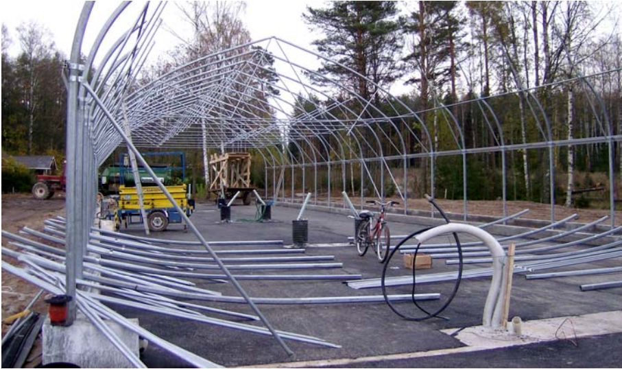
Kuva 10. Teräsrunгон kaariosien asennus käynnissä. (Kuva: Samuli Näri)
