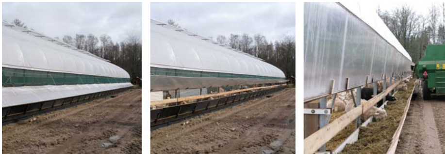
Kuva 26. Ruokintakaukalon läppä aukeaa kammesta kiertämällä koko sivu kerrallaan, jolloin apevaunulla ajo sujuu tehokkaasti. (Kuva: Tapani Kivinen)
