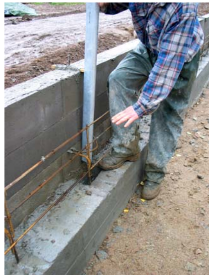
Kuva 6. Anturakaivua meneillään vasemmassa kuvassa ja anturan valumuotit paikallaan raudoitettuna oikeassa kuvassa. (Kuva: Samuli Näri)
