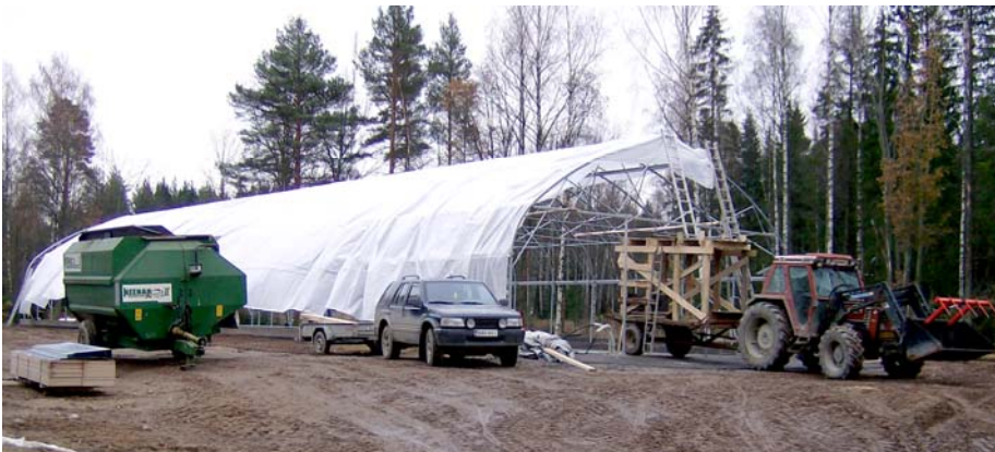
Kuva 11. Muovin asennusta. (Kuva: Samuli Näri)
