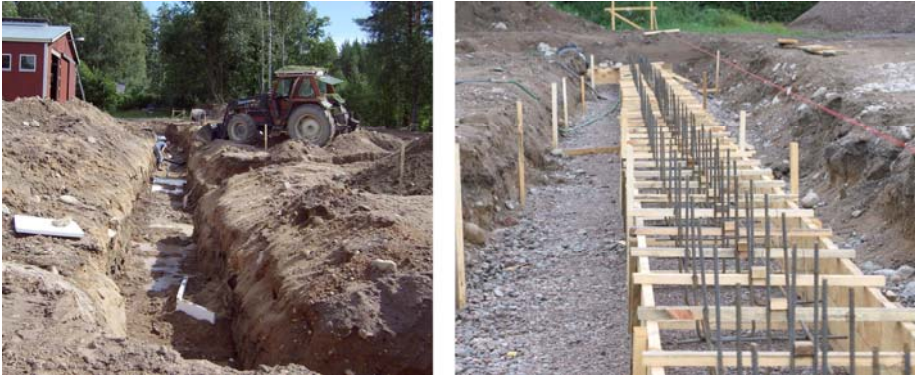
Kuva 6. Anturakaivua meneillään vasemmassa kuvassa ja anturan valumuotit paikallaan raudoitettuna oikeassa kuvassa. (Kuva: Samuli Näri)
