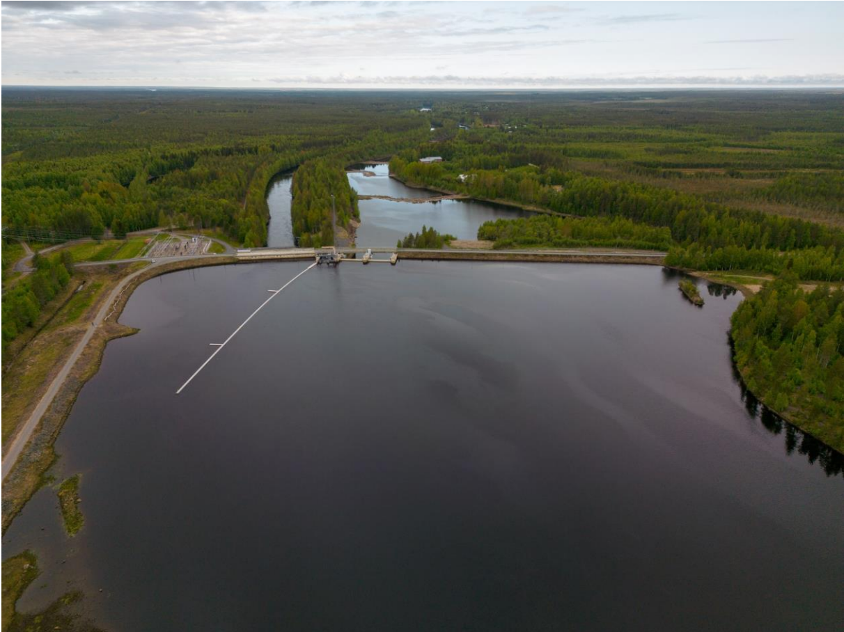
Kuva 2. Haapakosken alasvaellusratkaisu ylävirran suunnasta kuvattuna. Kelluva ohjausaita näkyy kuvassa vasemmalla ja se johtaa vanhaan tukinuittoränniin, mihin on toteutettu itse alasvaellusväylä kalojen alasvaellusta varten. Kuva: Jari Lindeman, Luke.
