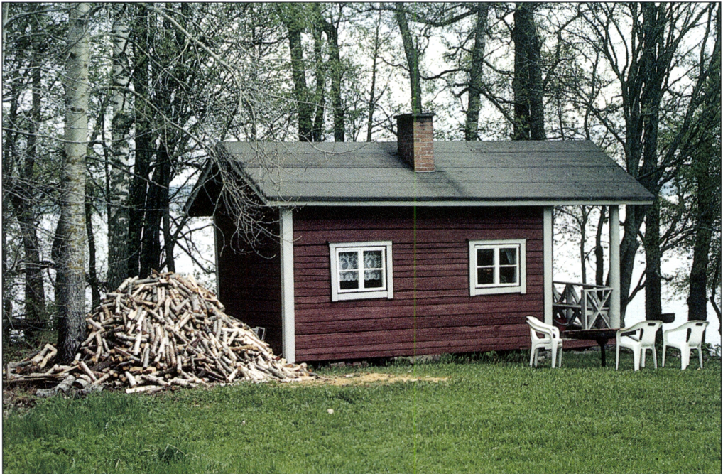
Kuva 21. Saunojen lämmitykseen käytetään vuosittain yli miljoona m 3 pilkettä (kuva Erkki Salo).
