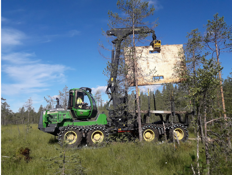
Kuva 3. CLT-levyt asennettiin ajouralle kuormatraktorilla. Kuvassa rakennetaan ajouraa vajaan 70 metrin levyisen suokaistaleen yli kenttäkokeella Lentokonejänkä 1. CLT-levyt nostettiin kuormatilasta ja asennettiin ajouralle kuormatraktorin eteen. Kuva: Jari Lindblad / Luonnonvarakeskus.
