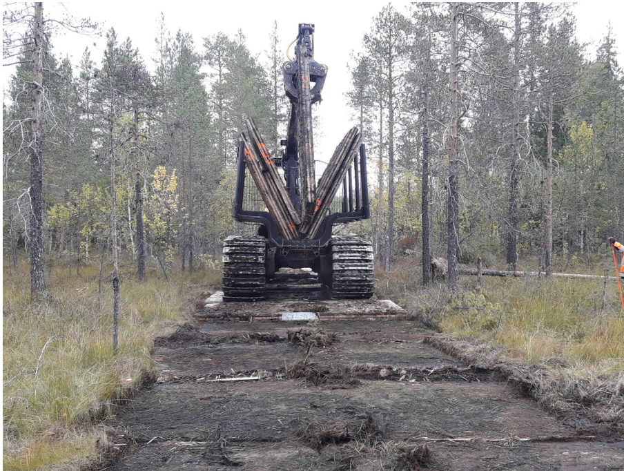
Kuva 4. CLT-levyistä tehdyt ajourat purettiin kuormatraktorilla. Kuvassa nostetaan CLT-levyä kuormatraktoriin kuormatilaan kenttäkokeella Lentokonejänkä 1. Kuva: Jari Lindblad / Luonnonvarakeskus.
