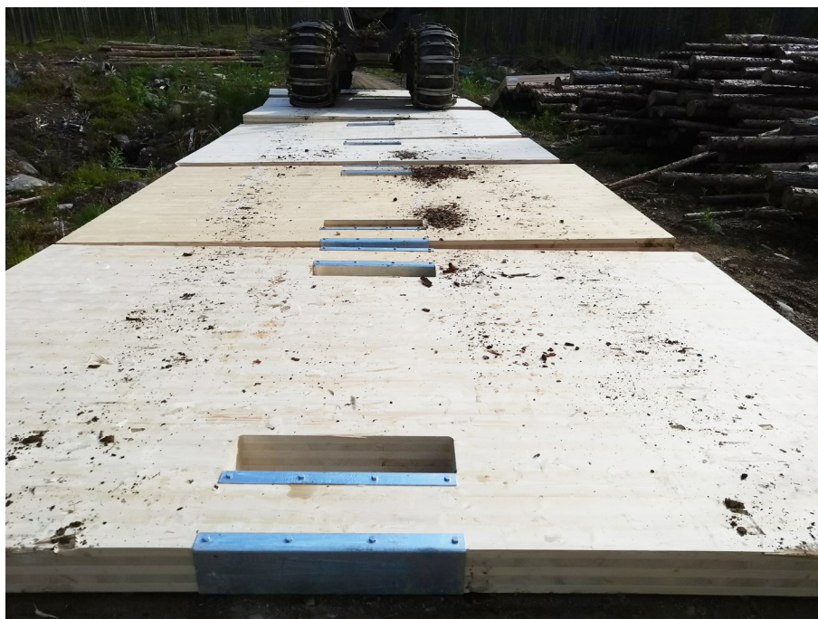
Kuva 1. Kantavuuden parantamiseen suunnitellut ja valmistetut CLT-levyt asennettuna ajouralle. Kerrosten määrä CLT-levyissä oli 4–7. Tartunta-aukot oli vahvistettu metallilla. Kuva: Anu Hilli / Suomen metsäkeskus.
