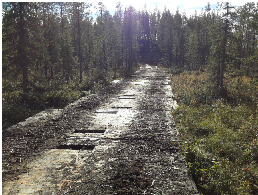
Kuva 5. CLT-levyistä tehty ajoura kenttäkokeella Lentokonejätkä 2 ajotestien ja yleisödemostraaation jälkeen. 70 metrin pituinen ajoura ulottui hyvin kantavalta tienvarsivarastolta kivennäismaan korjuulohkolle. Levytetyn ajouran keskivaiheilla oli siltalevyillä tehty puronylitys. Kuva: Jari Lindblad / Luonnonvarakeskus.
