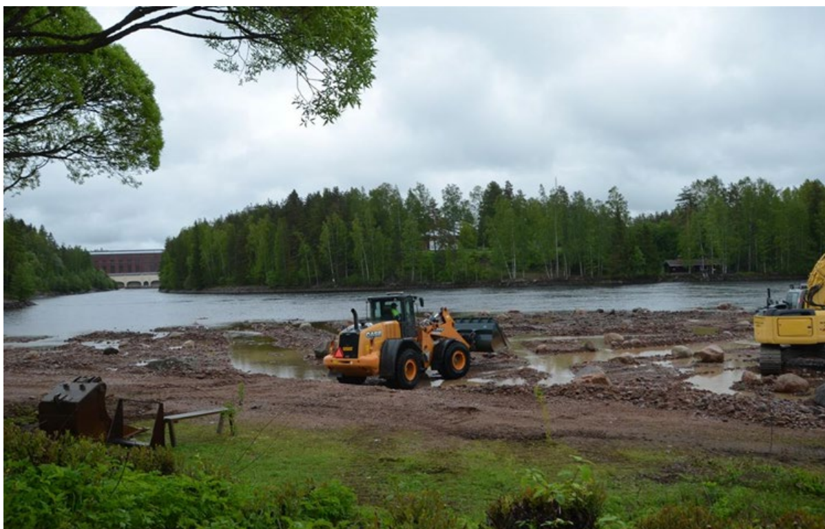
Kuva 45. RiverGo-hankkeessa kunnostetun Mellonlahden matalikon kunnostustyö käynnissä Vuoksella. Kuva: Imatran kaupunki.
