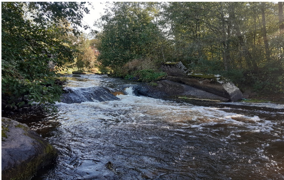
Kuva 15. Viisjoen nousuesteenä olleen patorakennelman jäännökset. Kuva: Pekka Vähänäkki.
