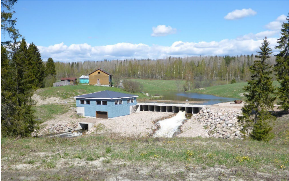
Kuva 11. Useimmissa Vuokseen laskevissa sivu-uomissa on nousueste, uudempi tai vanha suomalainen myllypato. Kuvassa uusi pieni sähkövoimalaitos Lesogorskin voimalaitoksen alapuolelle laskevassa Bezominannoe-joessa. Kuva: Pekka Vähänäkki.
