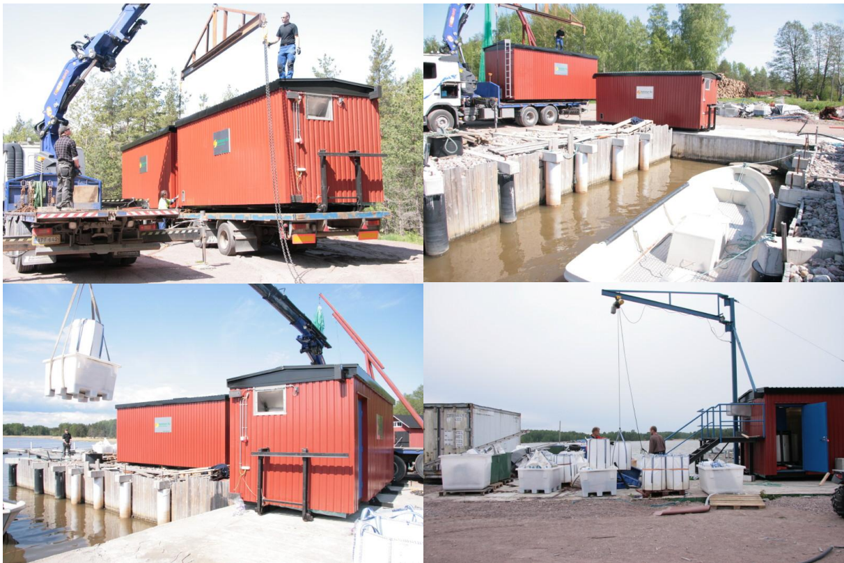
Kuva 8. Hapotusyksikön asennus Kopparnäsin rantaan. (Kuvat: Klaus Berglund).
