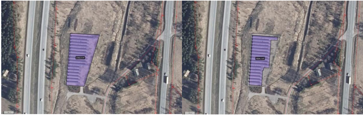
Kuva 11. Keravan aurinkovoimalassa 2/3 rakennuspaikan alasta on paneeleja (Maanmittauslaitos 2024).
