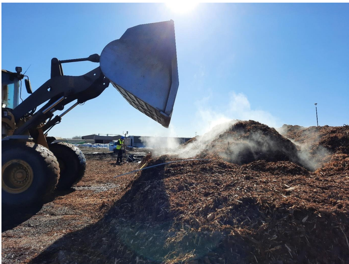
Kuva 11. Uimaharjun koeauman rakentamista. Kokeessa käytetty kuori oli peräisin korkeintaan vuorokautta aikaisemmin sahatuista tukeista, mutta sen lämpeneminen oli jo käynnistynyt.
