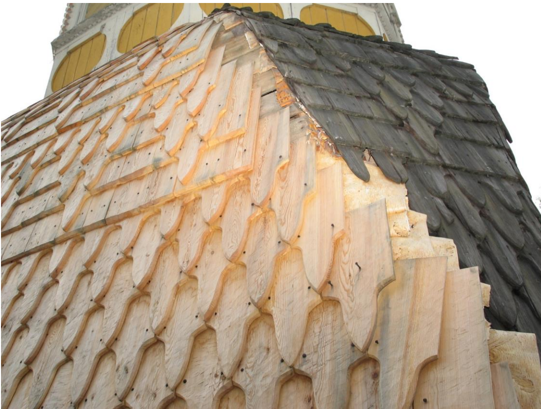
Kuva 18. Kesälahden kirkon kellotapulin mäntypaanukattoa vaihdettiin uuteen vuonna 2006. Vanhan, männyn sydänpuusta valmistetun, katon iäksi määritettiin 170 vuotta. Aluskatteena käytettiin koivun tuohta. Sinistymien perusteella uudet paanut näyttivät sisältävän myös pin-tapuuta.
