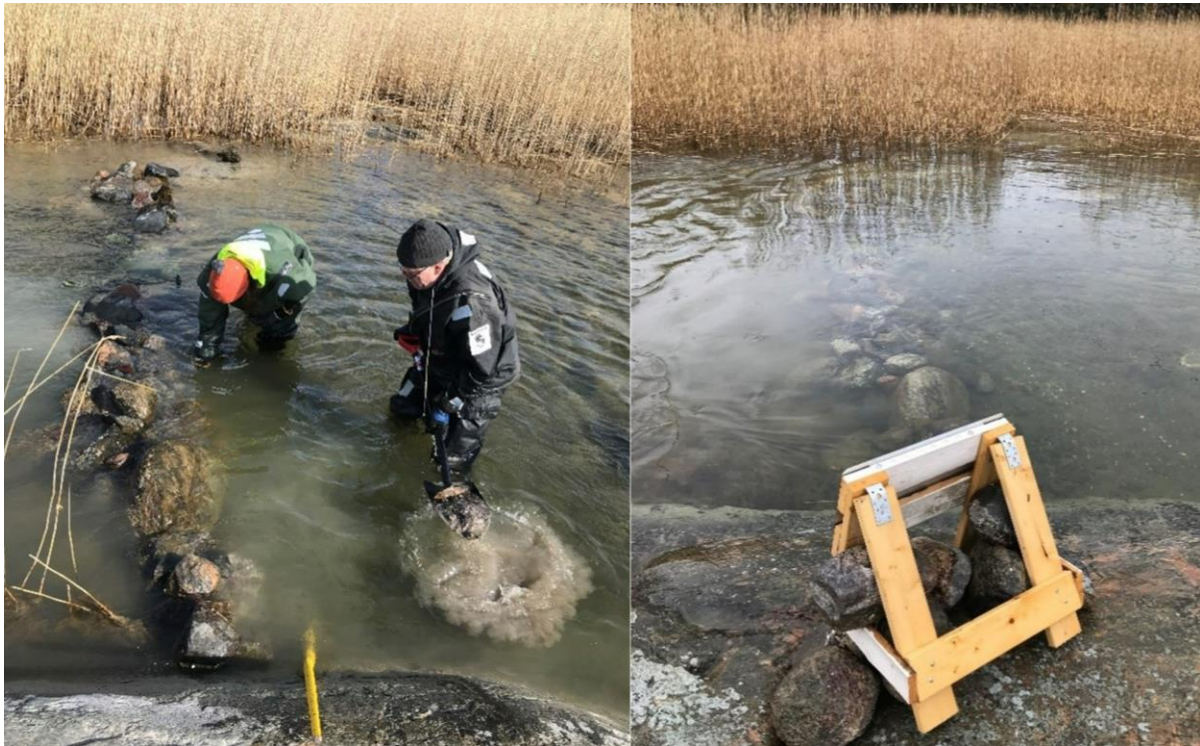
Kuva 20. Ytteröfladan suuaukon patoaminen kivillä, hiekkasäkeillä ja irtosoralla (vasen kuva). Veden virtaus fladan ja meren välillä oli ajoittain voimakasta (oikea kuva) meriveden pinnan noustessa padon yläreunaa korkeammalle. Kuvat: Mats Westerbom.
