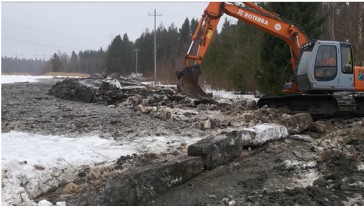
Kuva 46. Kunnostus Sävvikenissä tehtiin helmikuussa 2021 ja laskupuron kiveäminen huhtikuun alussa. Altaan kaivamisessa käytettiin kahta kaivinkonetta. Kuvassa kaivinkone siirtää fladankynnyksen kohdalle graniittipalkkeja. Kaivinkoneen takana näkyvä maavalli on jäätä ja kasvillisuusmassaa. Kuva: Lari Veneranta.
