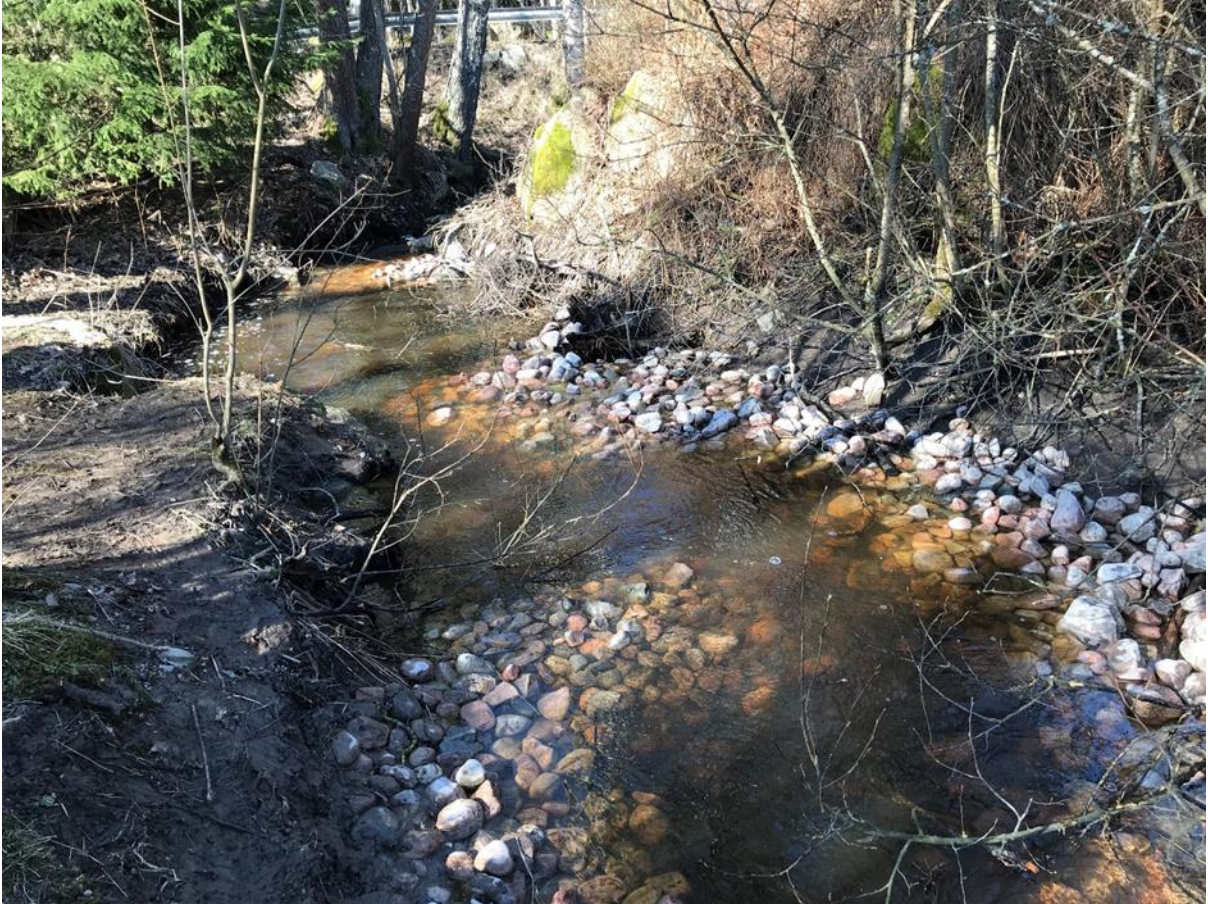
Kuva 29. Byträsketin kluuvijärven uoma kavennettiin kivimateriaalilla keväällä 2020. Kuva: Mats Westerborn.
