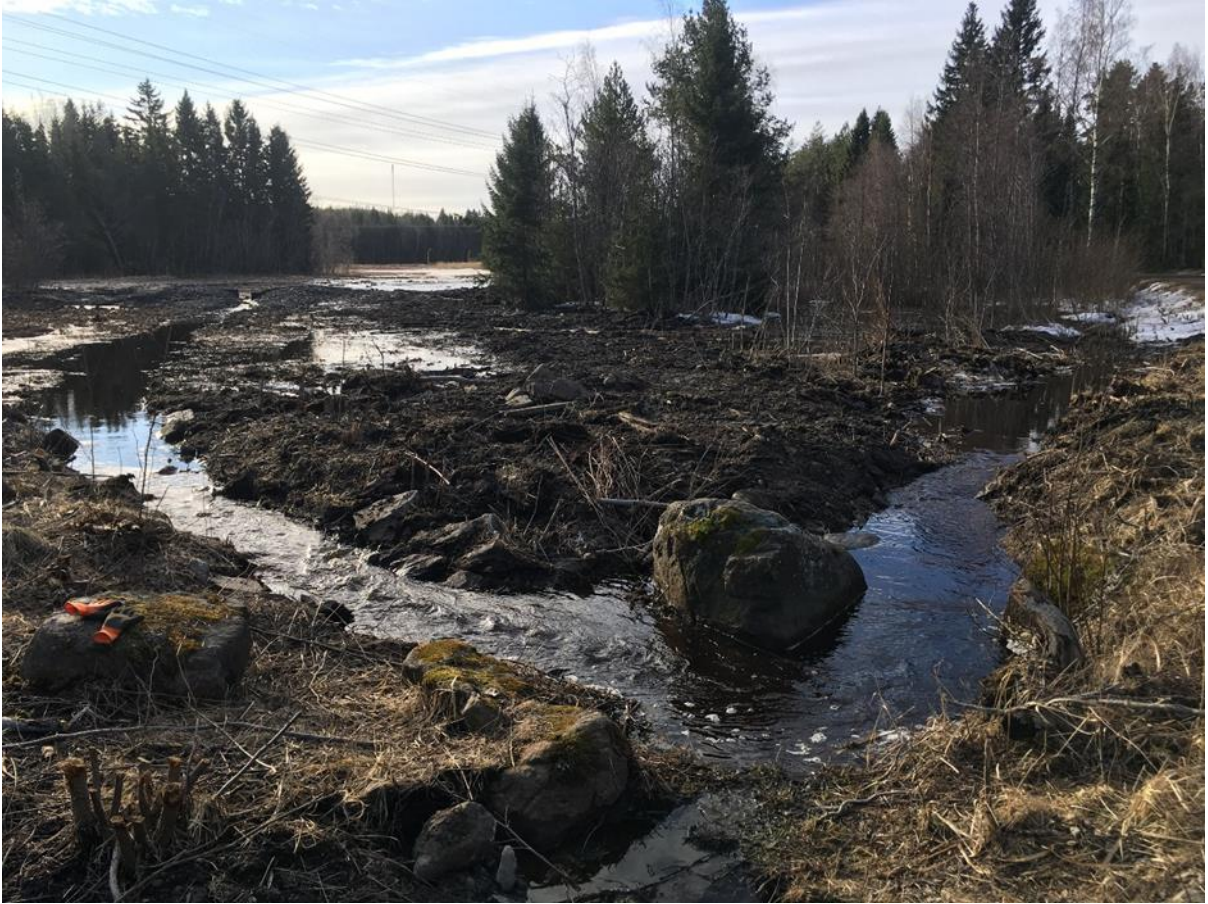
Kuva 47. Sävvi­ken kunnostuksen jälkeen huhtikuussa 2021. Lasku-uoman lisäksi ohivirtaamaa tuli kuvan oikeassa reunassa näkyvän maantieo­jan kautta. Ohivirtaama estettiin patoamalla vuotokohta altaan reunalta maamassalla. Kuva: Lari Veneranta.
