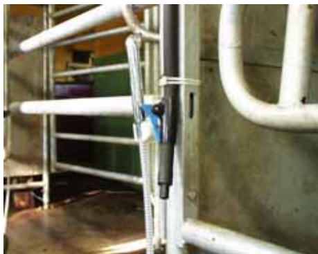
Bild 2. Vakuumkranen är placerad på lämplig höjd.
