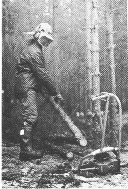
Figure 6. The Jaaranen-Rantapuu felling frame lightens and speeds up manual felling and bunching. Kuva 6. Jaaranen-Rantapuu kaatokabvojen käyttö keventää ja nopeuttaa kaatoa ja kokonaisten puitten kasausta.
