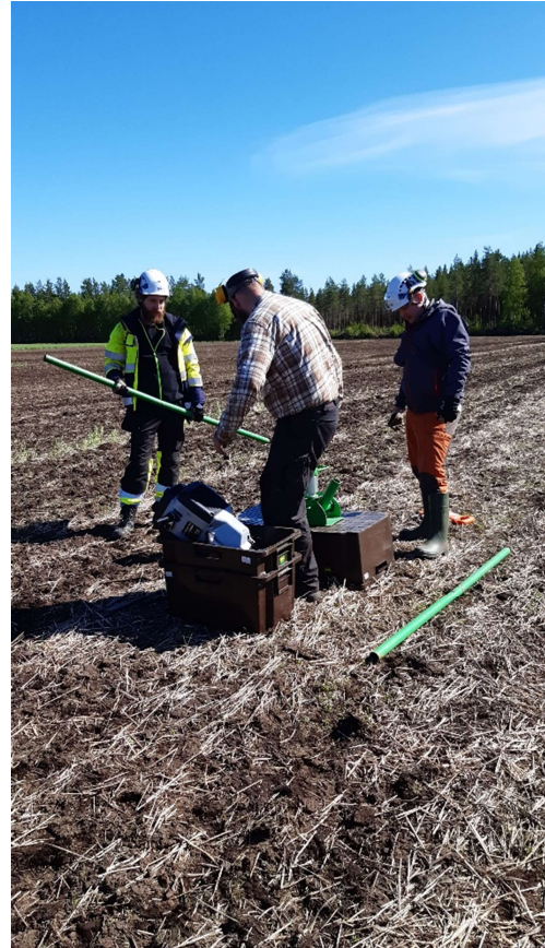
Kuva 6. Pohjavesiputkien asentaminen moottorikairalla viljelijän pellolle (Kuva: Maarit Liimatainen, Luke).
