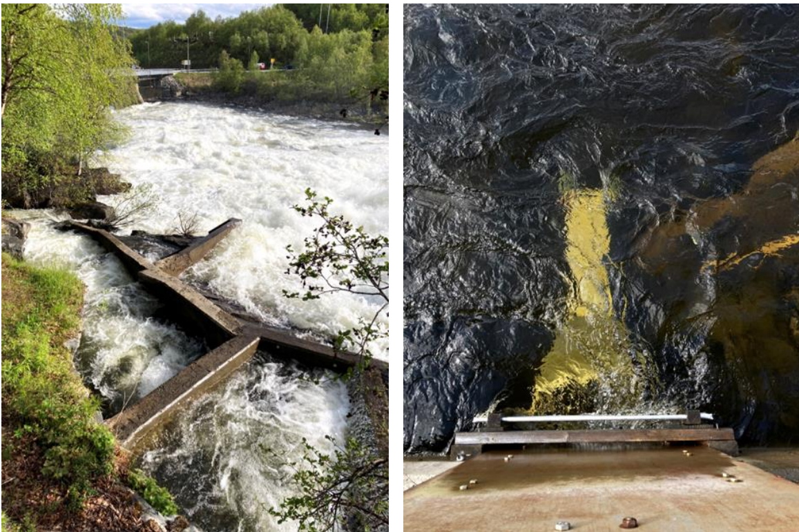
Kuva 9. Kolttakönkään kalatie ja sen yläpään asennettu puoliautomaattinen laskuri. Kalat nousevat viimeisestä altaasta kuvassa oikealla näkyvään tunneliin, missä kamera tallentaa läpi uivasta kalasta lyhyen videoklipin. Kuvat: Mikko Kytökorpi.
