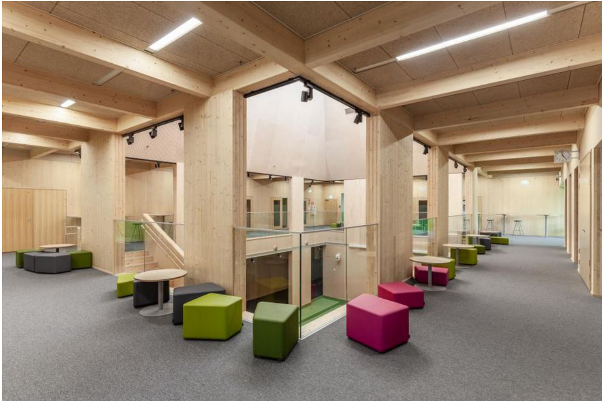
Kuva 13. CLT-rakenteinen Kuhmon Tuupalan alakoulu ja päiväkoti sai Puupalkinnon 2018. Arkkitehtitoimisto Karsikas Oy. (Valokuva: Puuinfo Oy)
