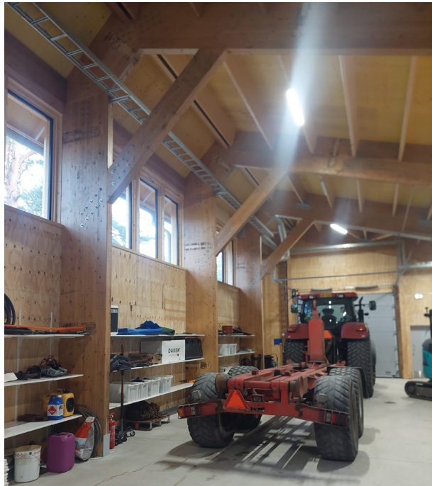
Kuva 15. Mustikkamaan huolto- ja varastorakennus Helsingissä on vuoden 2025 Puupalkinnon kunniamaininnalla palkittu rakennuskohde, joka edustaa kierrätyspuun käyttöä uudisrakentamisessa. Suunnittelu: Aalto-yliopisto. (Valokuva: Markku Karjalainen)
