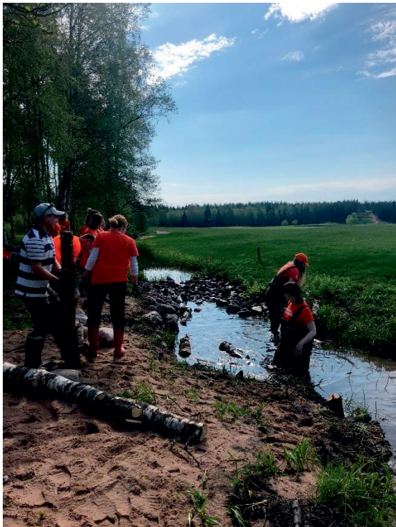
Kuva 4. Purouoman pohjaa ja reunoja kiiveämällä luodaan edellytyksiä taimenien kudelulle, ja muotoillaan puron virtaamia ja mutkittelevuutta monimuotoisuuden lisäämiseksi.
