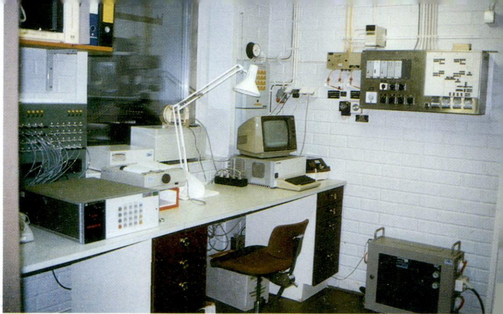
Pakkashallin valvomon säätö- ja mittalaitteita.
