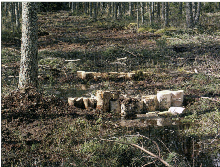
Kuviolle 837 jouduttiin rakentamaan keväällä 2005 täydentäviä patorakenteita, sillä osin jo tukkeutunut, kunnostusojituksessa aikanaan perkaamatta jäänyt oja oli alkanut johtaa tulvavettä pois ennallistetulta suoalueelta.
