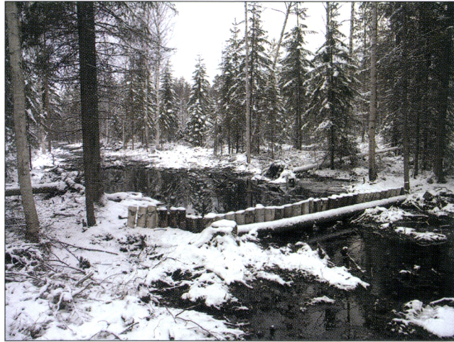
Kuviolla 844 sijaitseva, veden virtausta hidastava pintapato toukokuussa 2005 kevättulvan aikana ja lokakuussa 2005 vähäsateisen syksyn jälkeen. © Metla – Kalle Eerikäinen.
