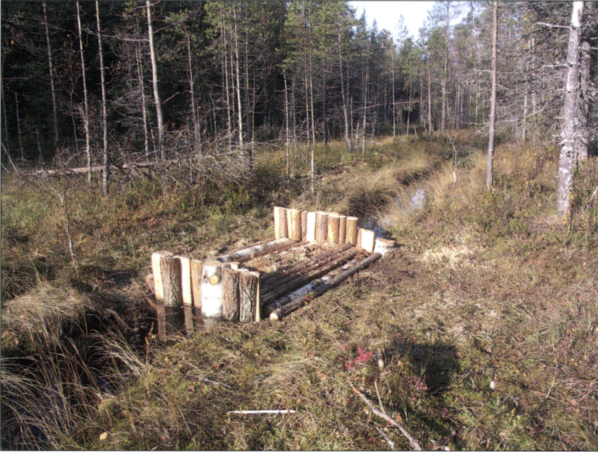
Tämä Ennallistajan polulla sijaitseva Pitkälammen suon ojapato estää veden kulkua ja toimii samalla polun käyttäjien kulkemista helpottavana siltana. © Metla – Kalle Eerikäinen.
