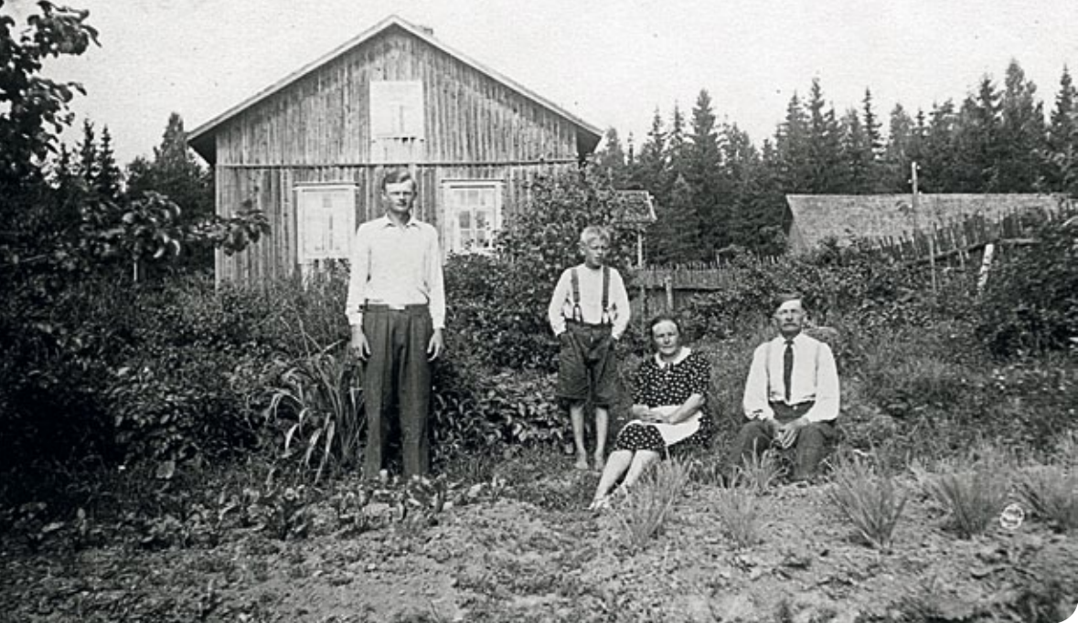
Hirvipolun isännän kessupeltoon on kuvauskesänä istutettu aivan muita hyötykasveja. Ryvässipulit ja punajuuret alkavat olla korjuuvalmiit. Emännän perennapenkissä kukoistaa rehevä päivänliilja. (Kuva: Anselm Laakso/Yläneen kotiseutuyhdistyksen kokoelmat)
