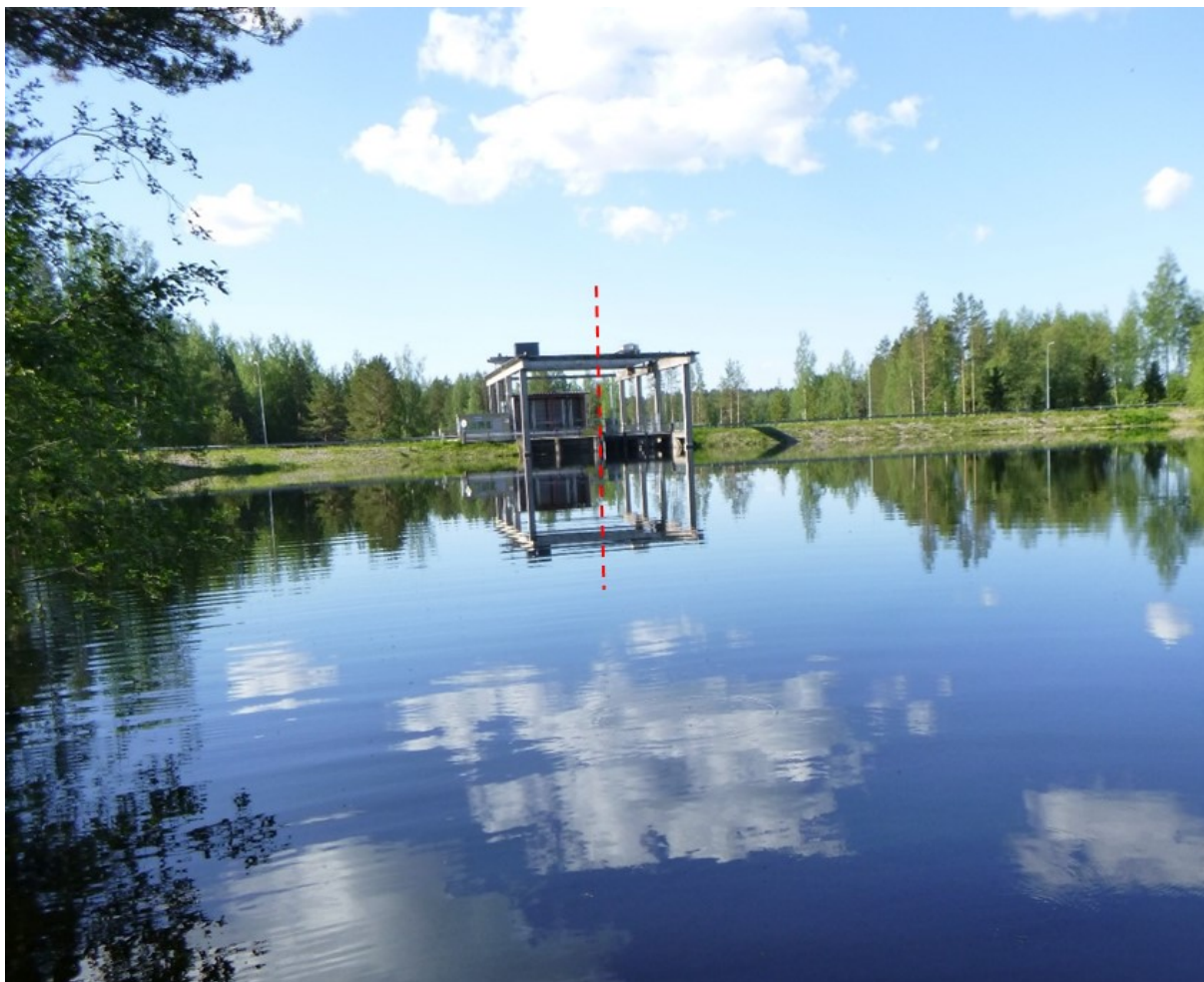
Kuva 3. Leuhunkosken voimalaitos patoaltaalta kuvattuna. Voimalaitoksen kaksiosainen tulokanava erottuu punaisen katkoviivan vasemmalla puolella. Ohijuoksutuskanava ja kalatien suuaukko sijaitsevat tulokanavan vieressä oikealla. Kuva: Petri Karppinen
