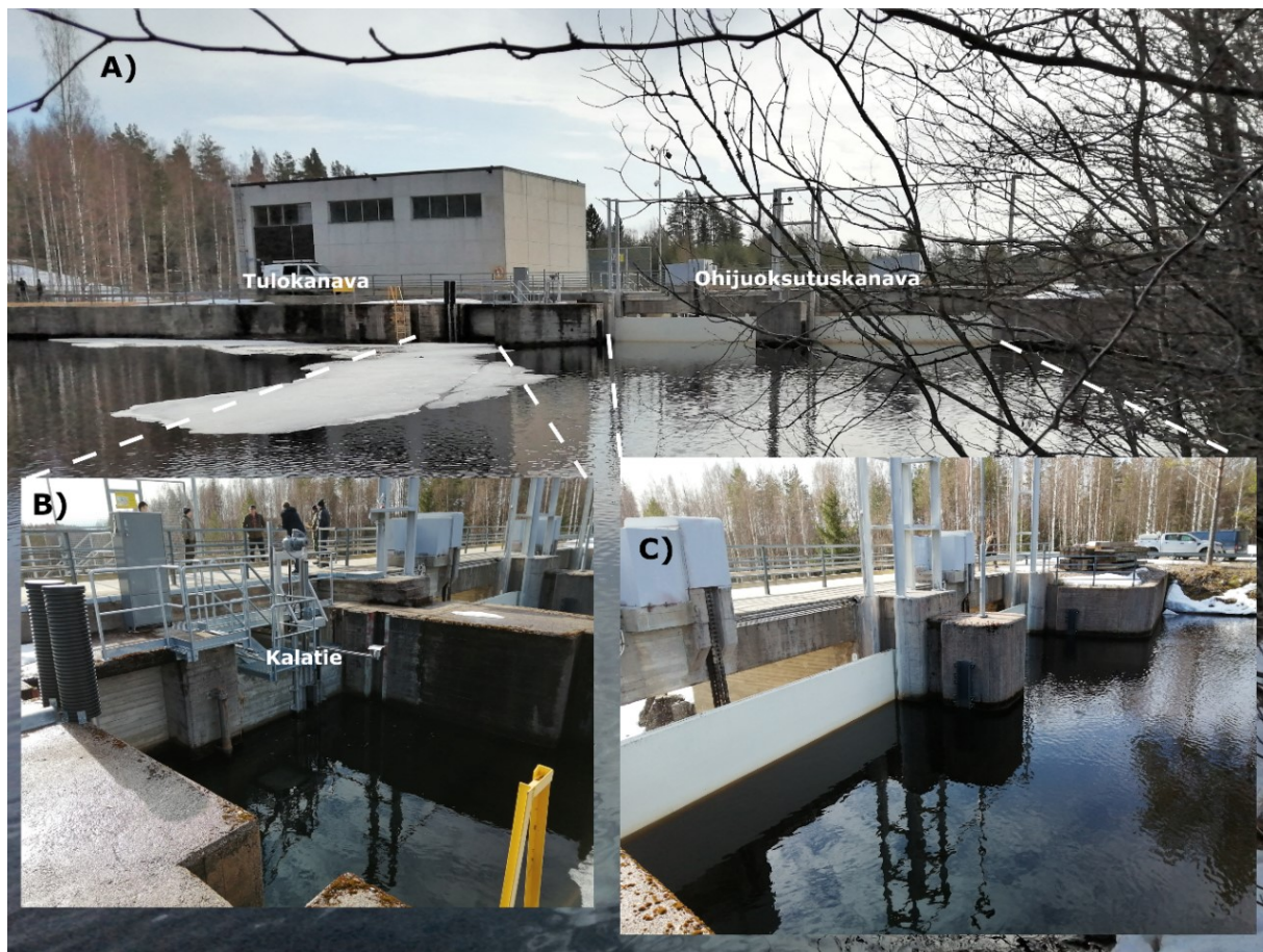
Kuva 5. Hietamankosken voimalaitospato (A) ylävirran suunnasta katsottuna. Kalatien yläpää (B) sijaitsee suunnilleen padon keskellä, ohjuksutusluukut yläkanavan oikealla laidalla (C) ja tulokanava vasemmalla laidalla. Kuva: Petri Karppinen.
