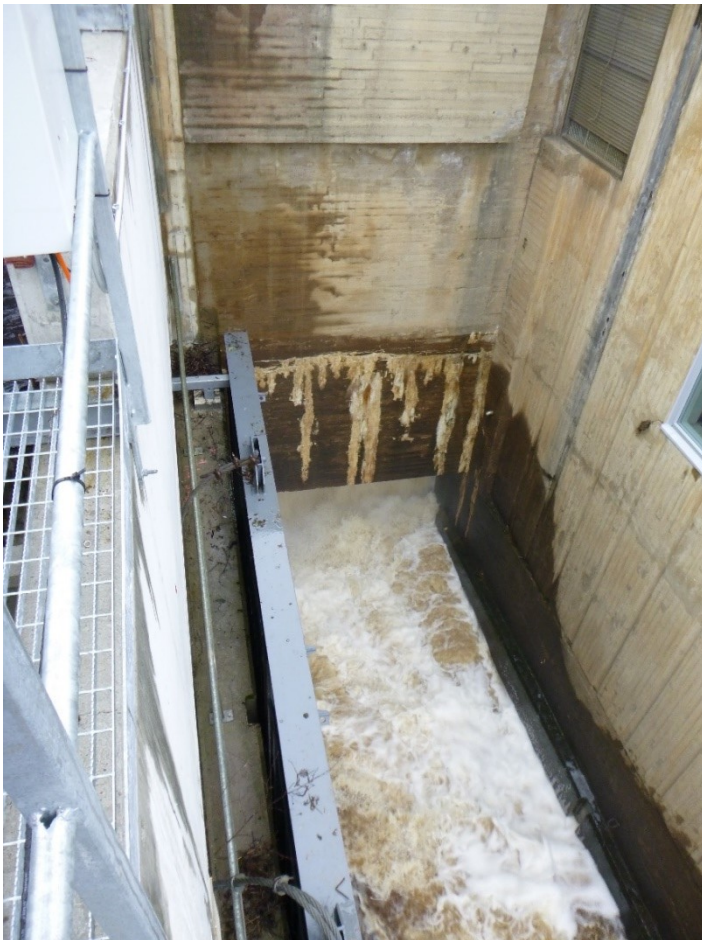
Kuva 11. Leuhun voimalaitoksen ohijuoksutuskanavaan purkautuu kovalla paineella pystysuora vesiputous patoluukun ollessa auki. Kuva: Petri Karppinen.
