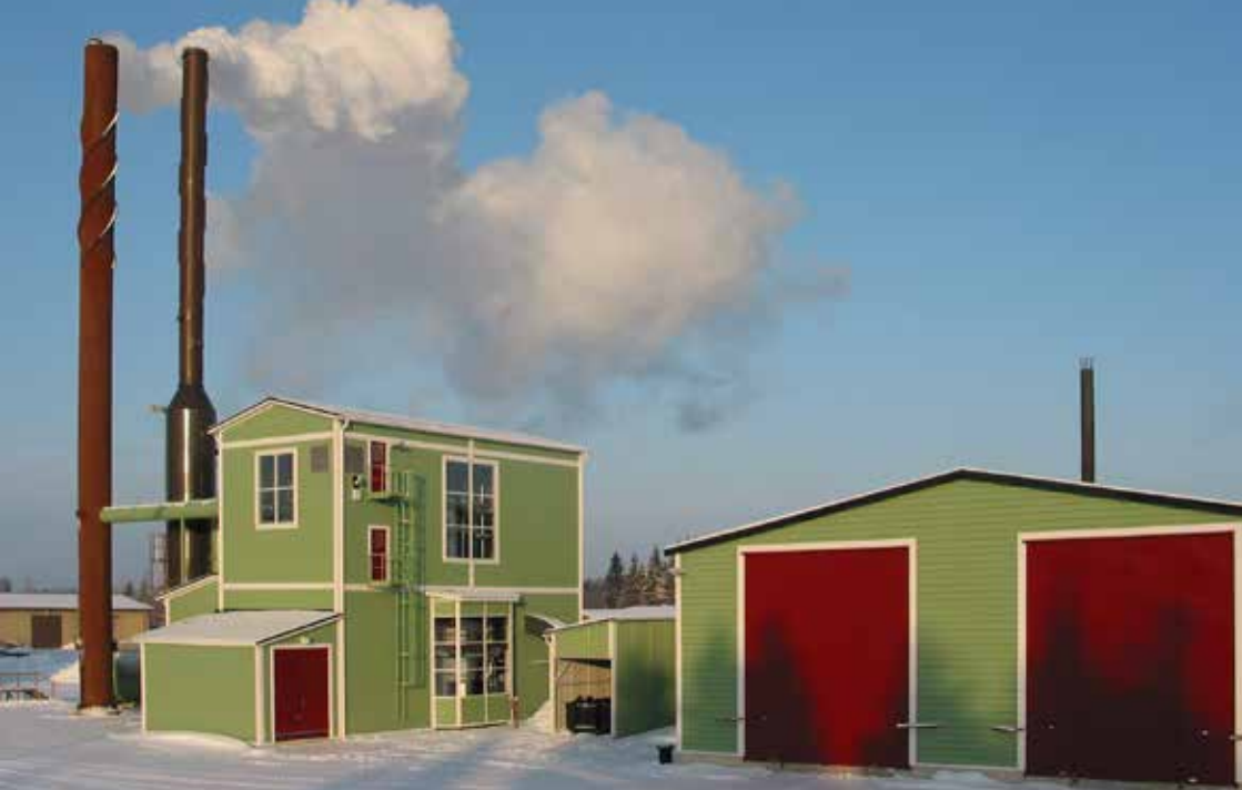
Рис. 3. Муниципальная котельная, работающая на щепе. (Фото: Juha Laitila)
