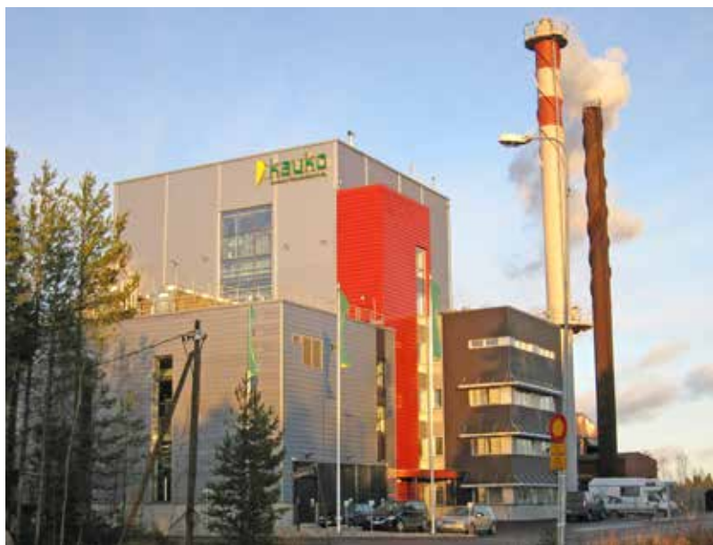
Рис. 1. Установка CHP одновременно вырабатывает тепло и электроэнергию. (Фото: Juha Laitila)
