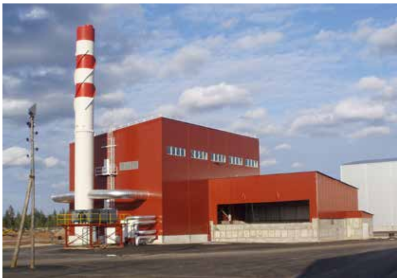
Рис. 4. Котельная при деревообрабатывающем предприятии производит тепловую энергию на нужды лесопильного производства и отопляет сибирский поселок Новая Игирма. (Фото: КРА Unicon Oy)
