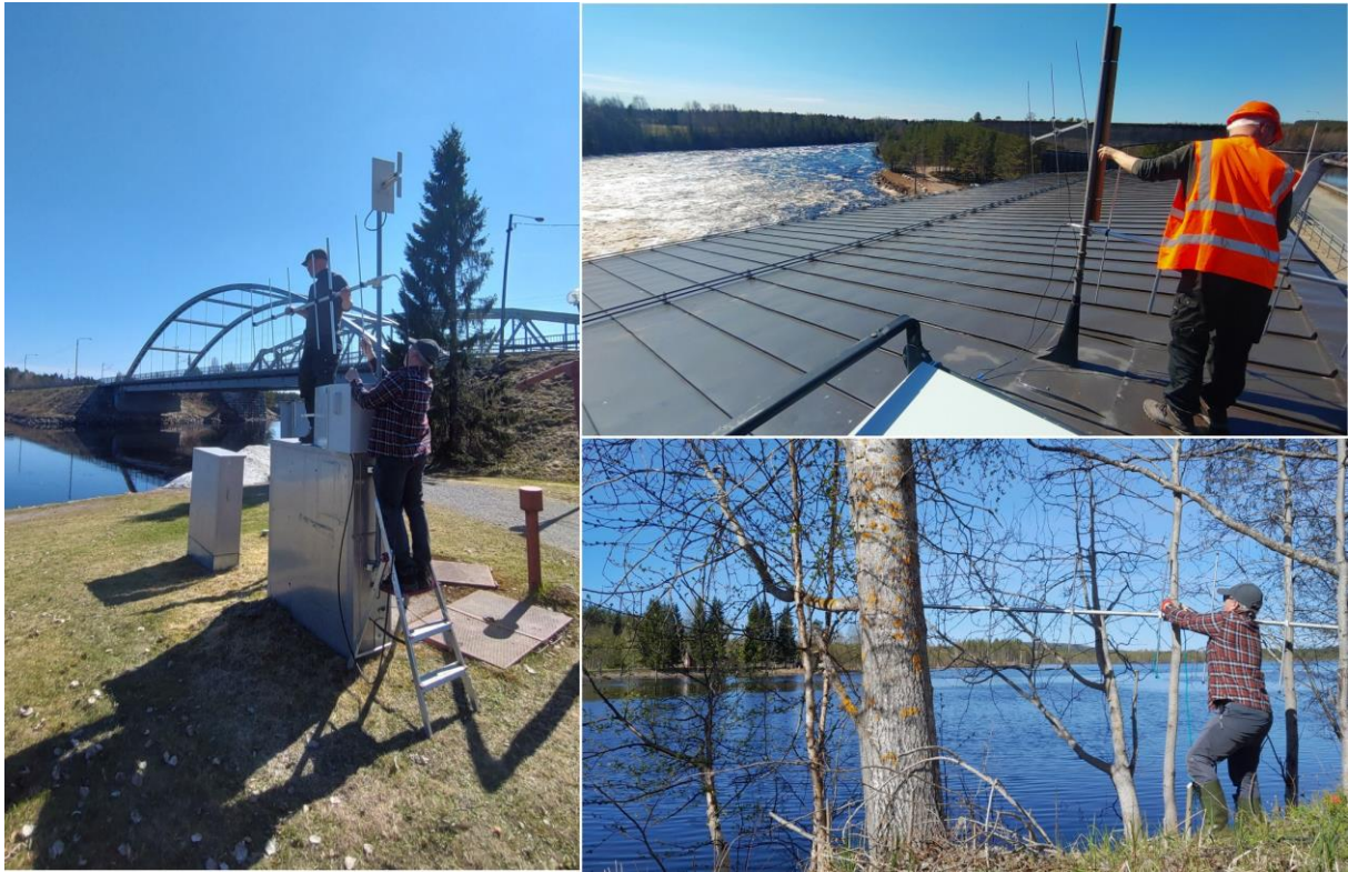
Kuva 3. Radiolähetinasemien asennusta Paltamossa jokisuulle (vasen), Leppikosken voimalaitoksen yläpuolelle (oikea ylä) ja Uurajärven alapuolelle (oikea ala).
