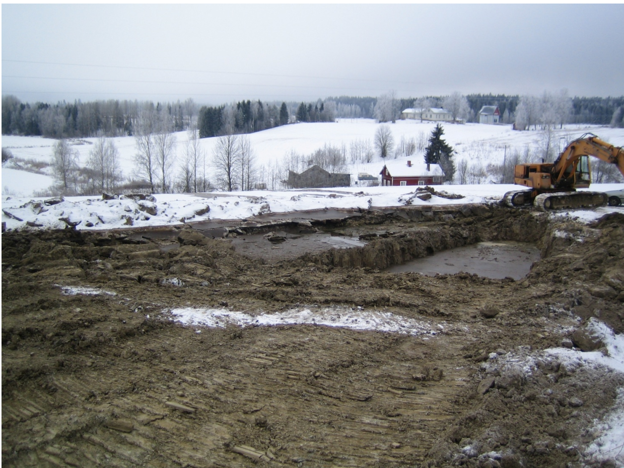
Kuva 2. Maanvaraisen lannan varastoaltaan maavalli on sortunut ja lietettä valuu maastoon. Kuva Heikki Uotila.
