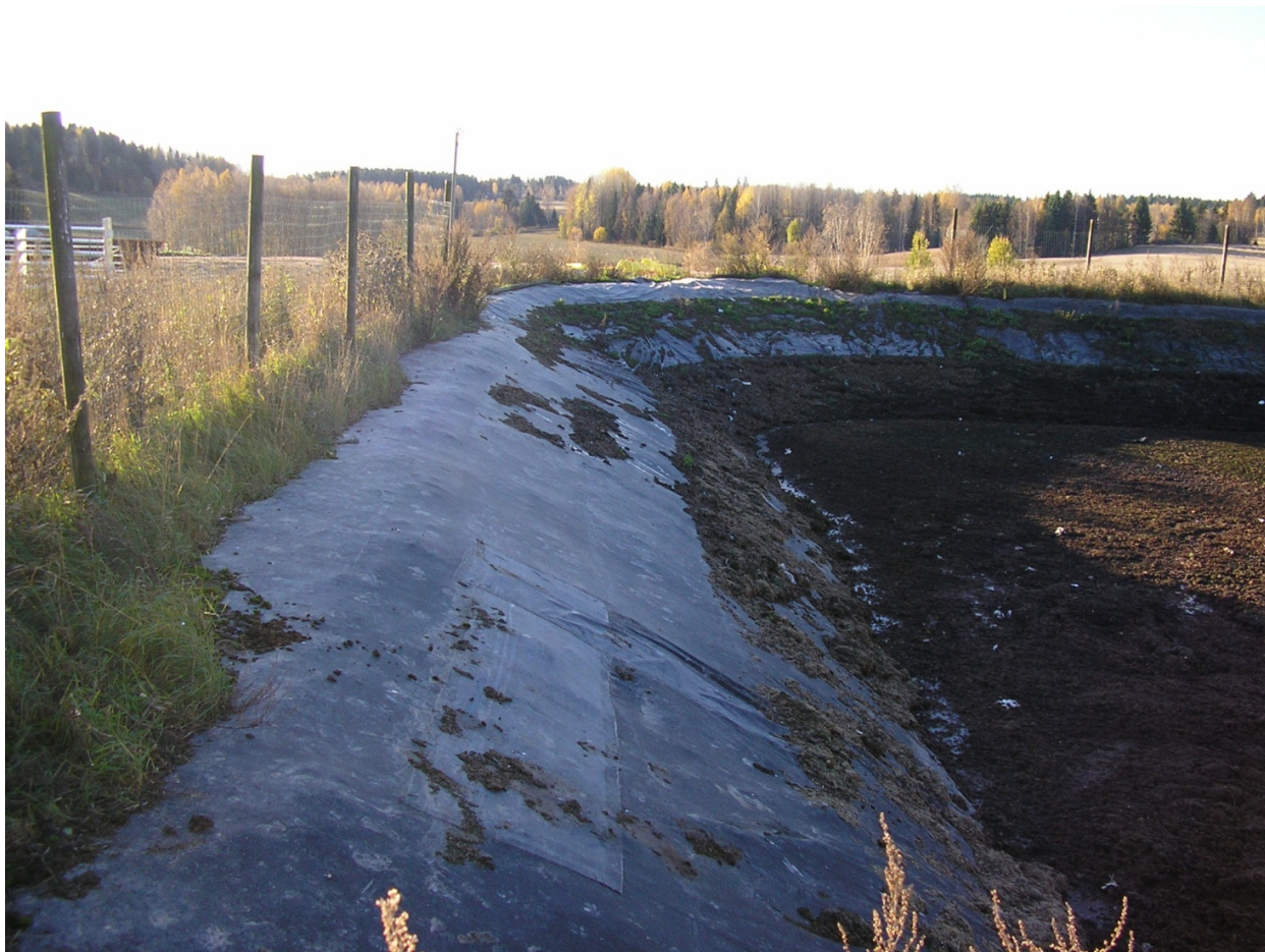
Kuva 5. Oikein paikattu maanvarainen lieteallas on käyttökelpoinen. Kuva Teemu Ala-Kleme.
