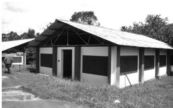
Kuva 3. Kompostointi tehtiin tiillisessä tarkoitusta varten rakennetussa tilassa, jonka tuuletus pelasi tiiliseinänsä jätettyjen aukkojen kautta.
