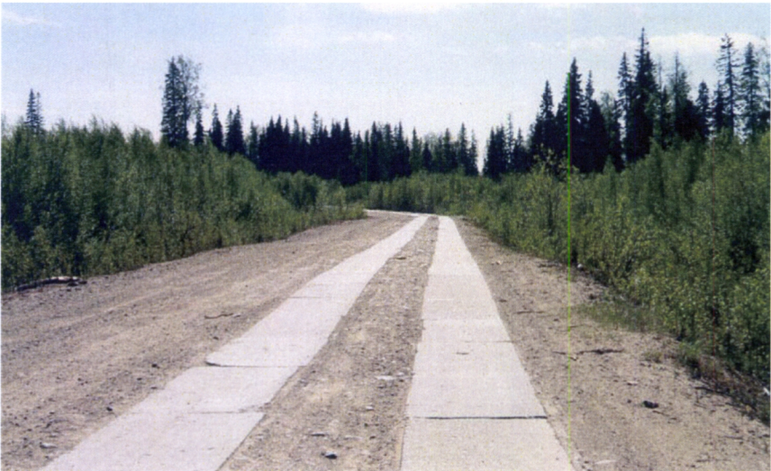
Kuva 28. Betonilaatoilla päällystettyjä metsäteitä käytetään alueilla, joissa ei ole saatavilla paikallista kiviainesta tien pohjaan. (Timo Leinonen)
