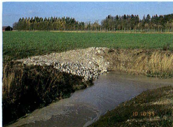
Kuva 5. Ojan mutkaa on valumavesien kertymis- kohdasta vahvistettu kiveyksellä.
