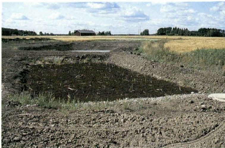
Kuva 9. Kosteikkokasviallas pinnassa istutus- ja alustana toimiva turve, järviruoko istutettu riveihin.
