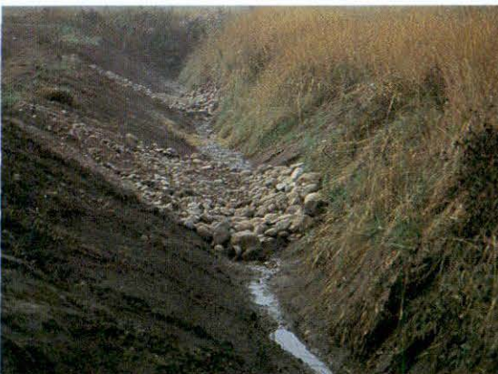
Kuva 4. Ojan pohjalle on kipattu kiviä, joista on muotoiltu pohjapato virtausnopeuden pienentämiseksi.
