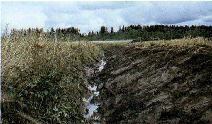
Kuva 3. Ojan toinen luiska on loivennettu kaltevuuteen 1:2 ja pohjasta on poistettu irtonainen maa-aines. Toinen luiska on koskematon.
