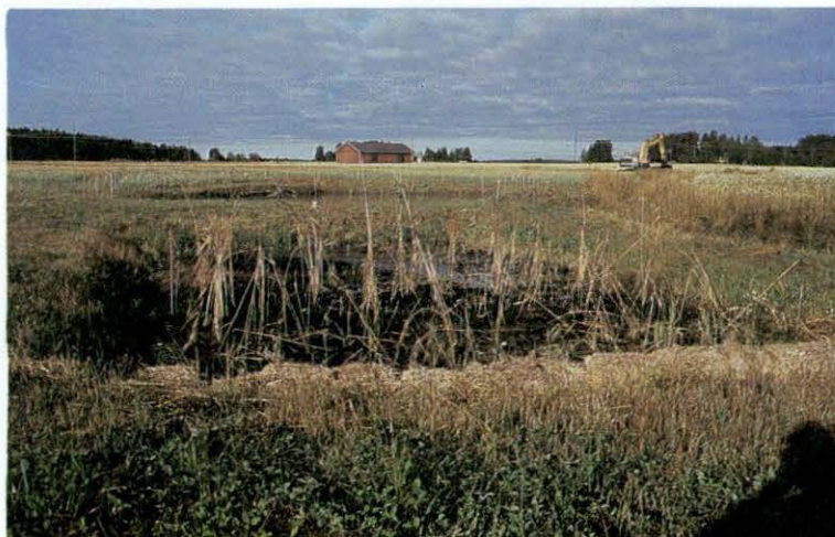
Kuva 11. Kosteikkokasviallas vuosi rakentamisen jälkeen. Osa järviruokokasvustosta on istutettu uudelleen.
