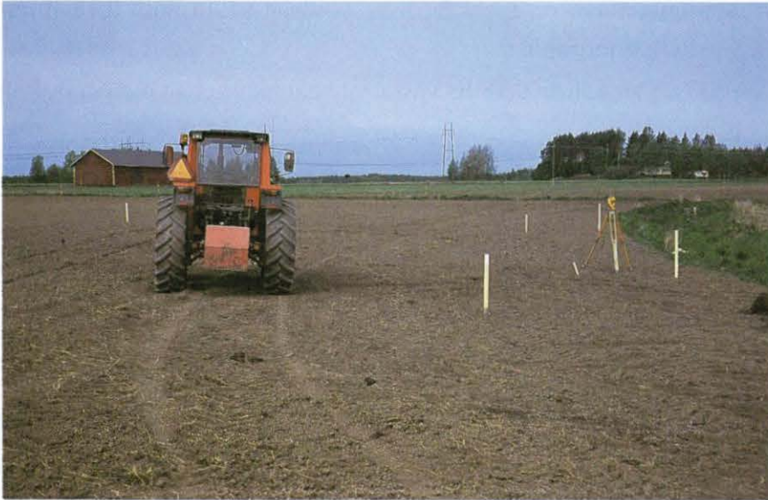
Kuva 6. Keinokosteikon rakennuspaikka ennen kaivuiden aloittamista.
