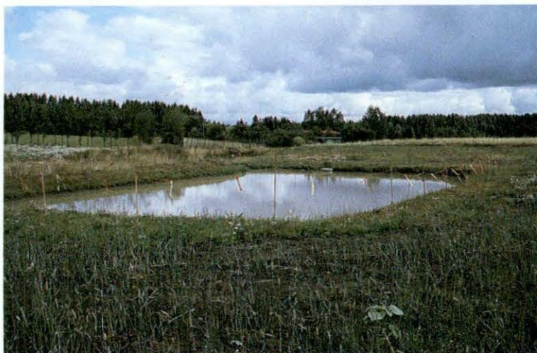
Kuva 12. Laskeutusallas vuosi rakentamisen jälkeen. Reunat on nurmetettu ja altaan ympäri laitettu varoitusmerkit, koska allas on verrattain syvä.
