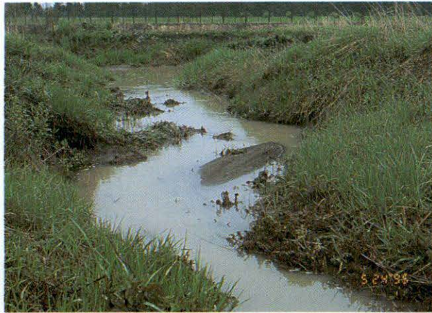
Kuva 2. Tulvavesi on tuonut mukanaan pellolta ja ojan reunoilta irtonaista maa-ainesta, joka on laskeutunut ojan pohjalle.
