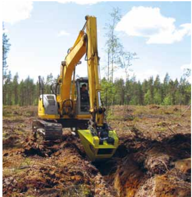
Kuva 3. Ojan kaivuuta monitoimikauhalla. (valokuva Pekka Helenius)
