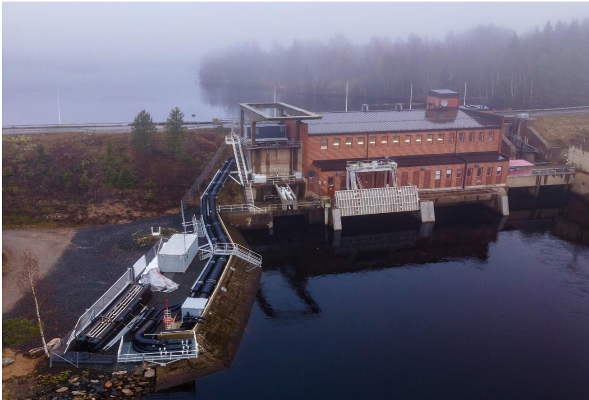
Kuva 4. Leppikosken vesivoimalaitoksella on otettu käyttöön hydraulinen Kalasydän järvitaimenen ja muiden kalojen vaelluksen mahdollistamiseksi. Kuvassa Kalasydän ei ole toiminnassa. Kuva: Jari Lindeman, Luke
