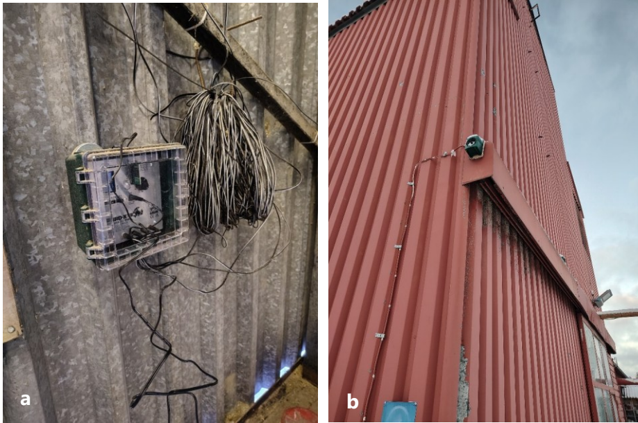
Kuva 6. BirdX BroadBand Pro -lintujen karkotuslaitteiston ohjausyksikkö kiinnitettiin säänsuojaan viljankuivaamoon sisätilaan (a) ja kaiuttimet eri puolille viljankuivaamons ulkoseinään (b). Kuvat: Leena Tuomisto/Luke.
