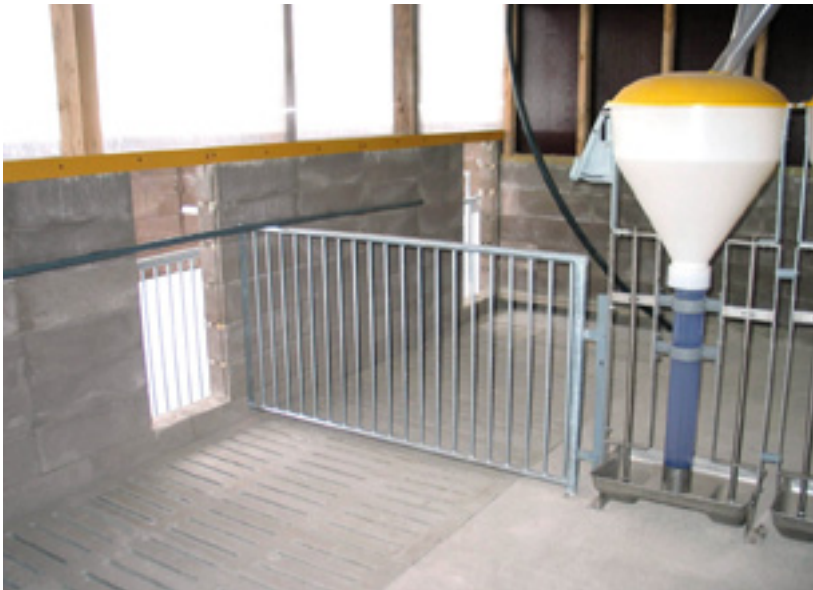
Kuva 17. Kuva lihasikalan toteutuksesta. Lanta-alue on varustettu ritilöillä ja sen alla on raappa. Luonnon valon määrä on runsas ja ylittää luomuvaatimukset monin verroin. Ulko- ja väliseinien alaosa ikkunakorkeuteen on betonihiharkkoa ja yläosa puurunkoa.
