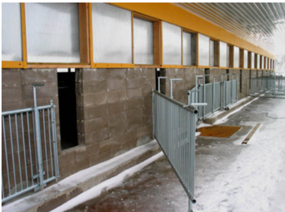
Kuva 49. Esimerkki 75 %:sti katetusta jaloittelualueesta, jossa eläinaidat teräspanputkea. Jaloittelualueelle on tarkoitus levittää runsaasti tonkimismateriaalia.
