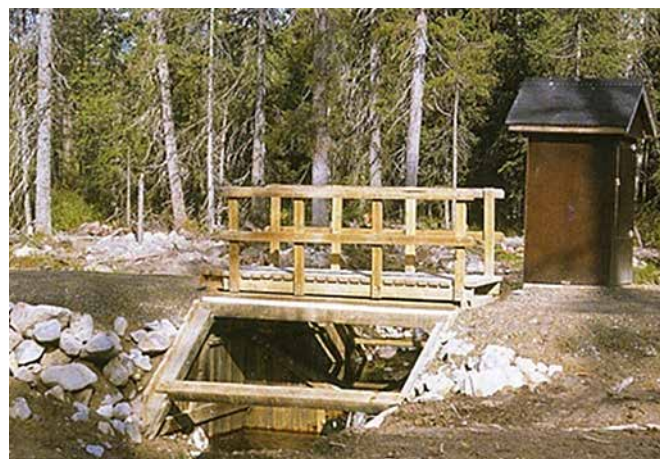
Kuva 7. Virtaamaa ja veden laatua seurataan lasku-uomaan rakennetulta mittapadolta. Kuva: Erkki Oksanen, Luke.
