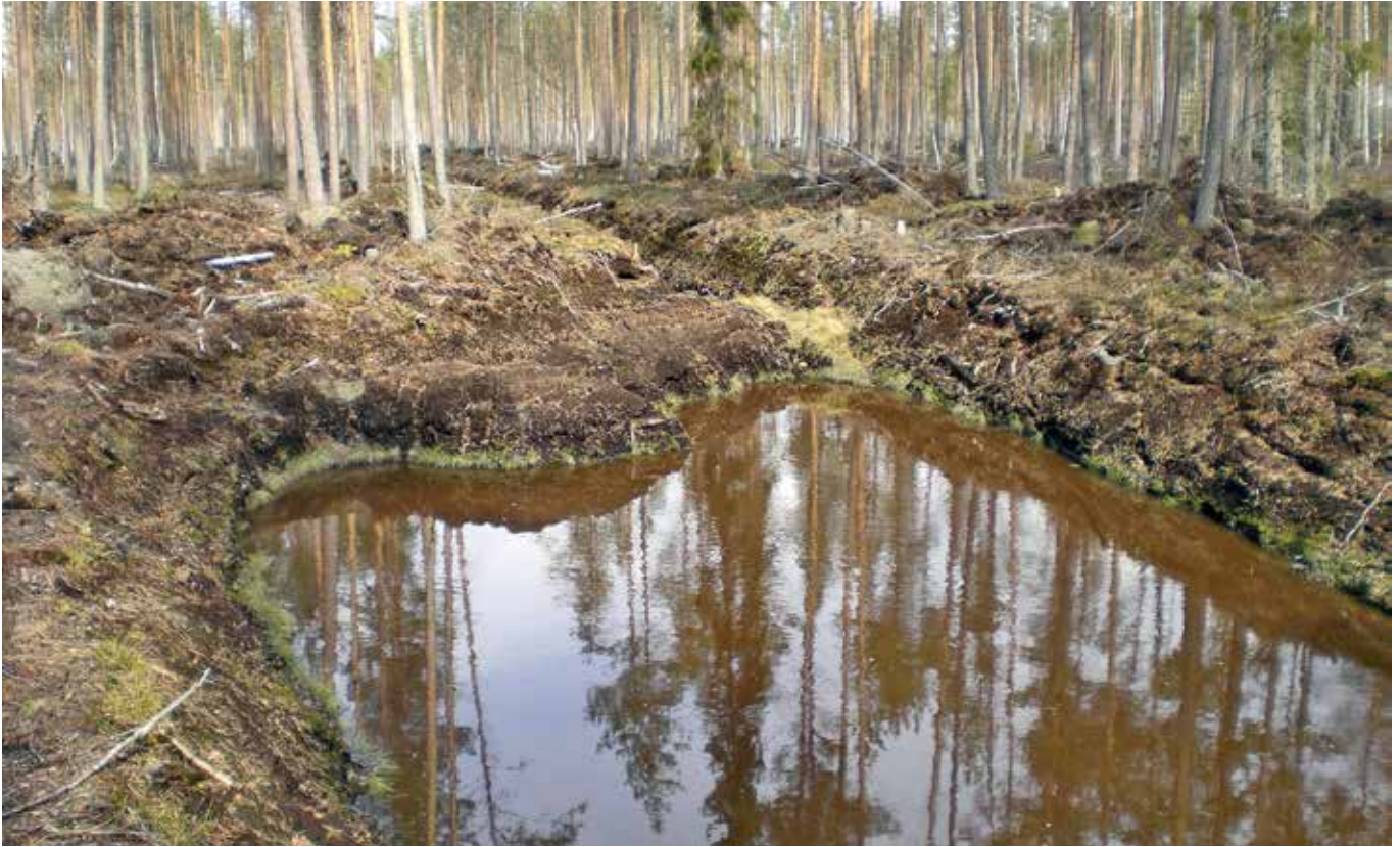
Kuva 8. Laskeutusaltailla pysäytetään kunnostusojitusalueilta tulevaa kiintoainekuormitusta. Kuva: Leena Finér.
