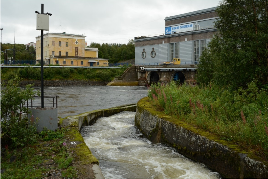
Kuva 2. Ala-Tuuloman voimalaitos ja kalatie alavirran puolelta kuvattuna. Kuva: Panu Orell.
