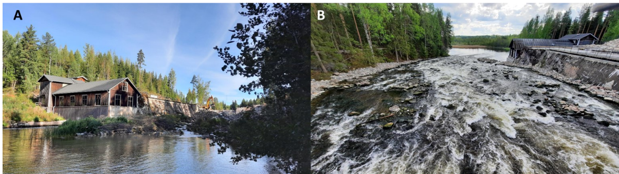
Kuva 3. Hiitolanjoen Lahnakosken pato poistettiin ja alue kunnostettiin kesällä 2023 vaelluskaloille soveltuvaksi lisääntymis- ja poikastuotantoalueeksi; A) pato on vielä paikallaan ja työt aloitettu, B) pato on poistettu ja vesi virtaa jälleen vapaasti uomassa. Kuvat: Pauliina Louhi.
