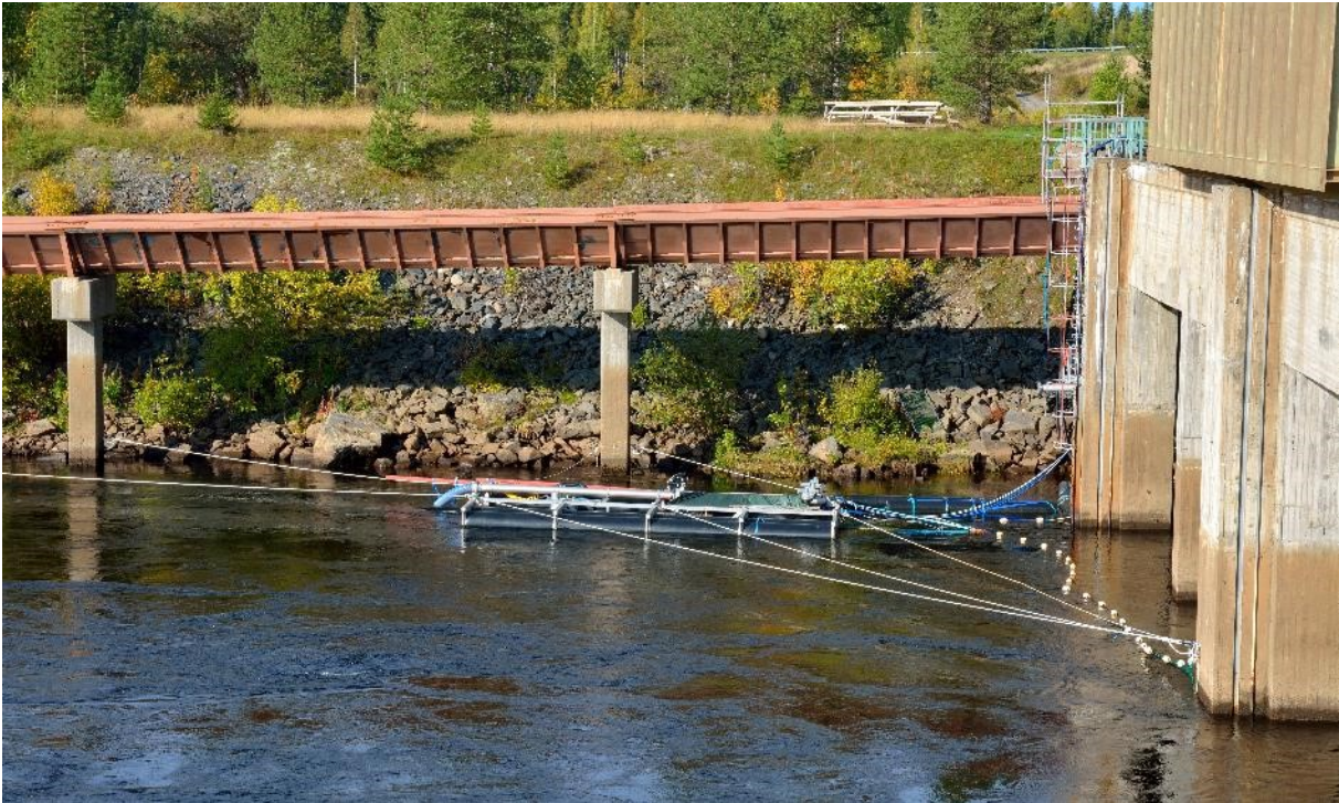
Kuva 4. Hydraulinen kalasydän-järjestelmä asennettuna Kemijoen Taivalkosken voimalaitokselle. Kuva: Panu Orell.
