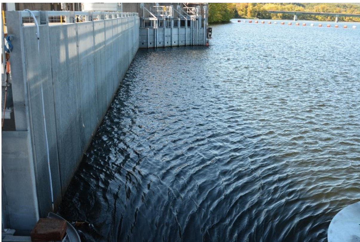
Kuva 8. Tiheä välppärakenne, jolla alusvaeltavat kalat pyritään ohjaamaan voimalaitoksen turbiinit kiertävälle reitille. Kuva: Panu Orell.
