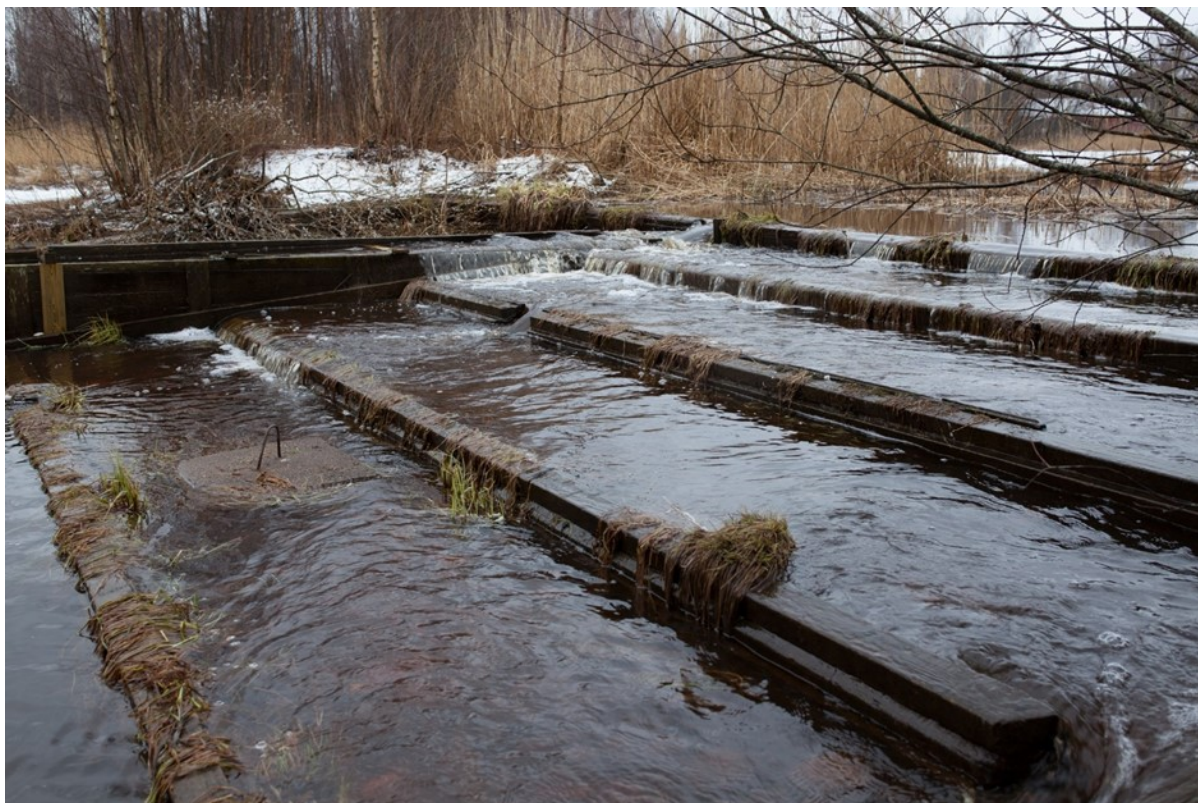
Kuva 7. Kevätkutuisille ahvenelle, haulle ja särkikaloille tarkoitettu kalatie meren ja yläpuolisen kluuvijärven välillä. Kuva: Lari Veneranta.
