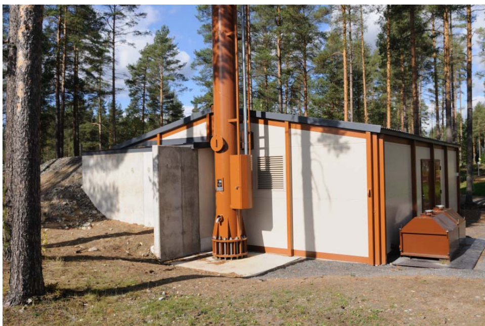
Рис. 73. Модульная котельная Maxicont 250 (Megakone Oy)
