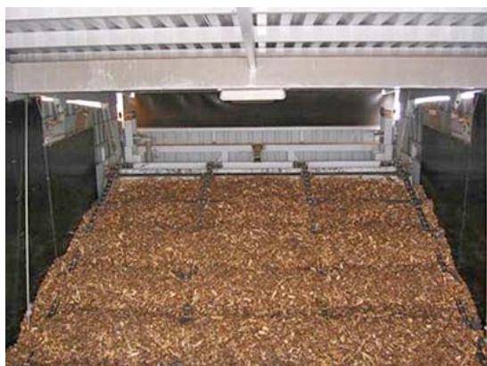
Рис. 38. Стандартная топка с механической решеткой (EUBIONET2)
