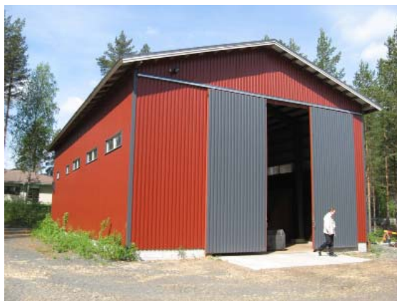
Рис. 68. Котельная Тойвакка 0,7 МВт (Юрки Райтила)
