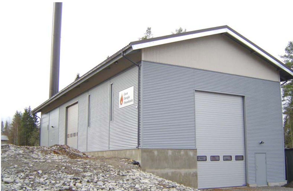
Рис. 50. Котельная кооператива ENO Energy (Urpo Hassinen)
