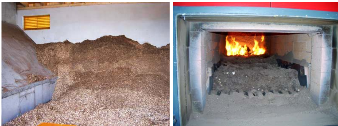
Рис. 63. Хранилище древесной щепы и топка котельной Хофштеттен-Грюнау (BIOENERGY2020+)
