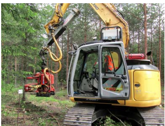
Рис. 21. Экскаватор, оборудованный дополнительной стрелой и накопительной харвестерной головкой (Juha Laitila)
