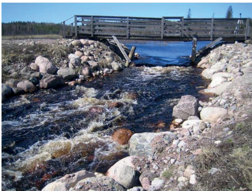
Kuva 44. Kosteikosta lähtevä uoma verhoiltiin kivillä lupaehtojen mukaisesti kalojen kulun parantamiseksi.
