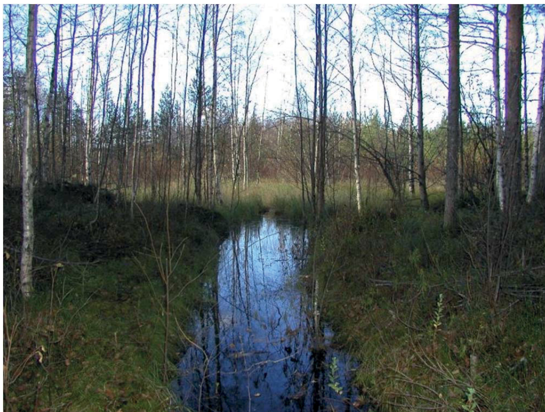
Kuva 11. Kuntalan kunnostusojitusalueen pintavalutuskenttä. Kentälle levitettiin 1000 kg/ha kipsiä fosforin pidättymisen tehostamiseksi. Kunnostusojitusalueen vedet on johdettu kuvan taka-alalla näkyvälle pintavalutuskentälle perkaamatonta ojaa pitkin (edessä).
