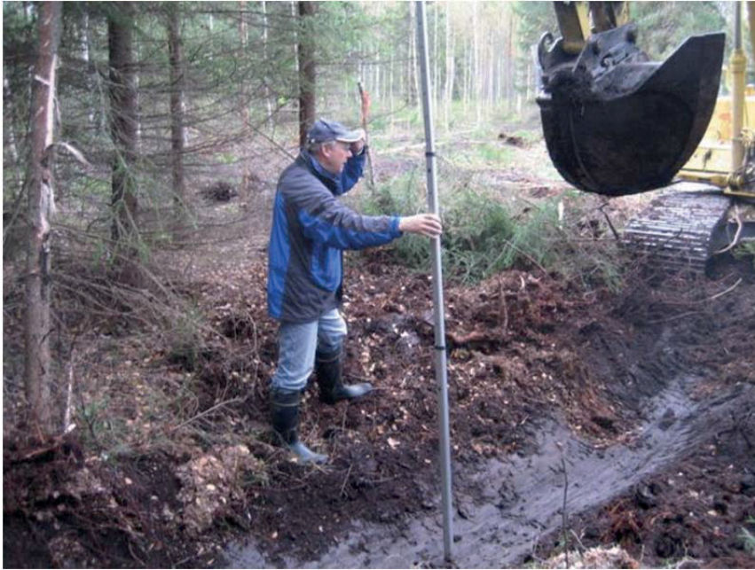
Kuva 31. Putkipadon toteutus edellyttää putken oikean koron vaakitsemista.
