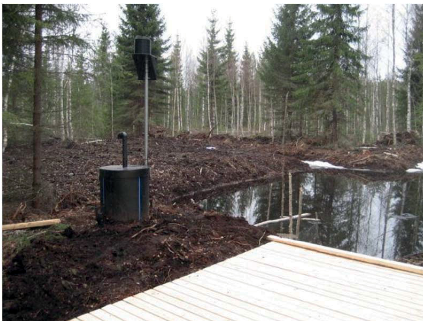
Kuva 33. Valmis laskeutusallas – putkipatorakenne (mittapato) Ukonsuolla. Huomaa hyvä maisemointi ja sen edellytyksenä riittävän suureksi hakattu aukko laskeutusaltaan ympärillä.
