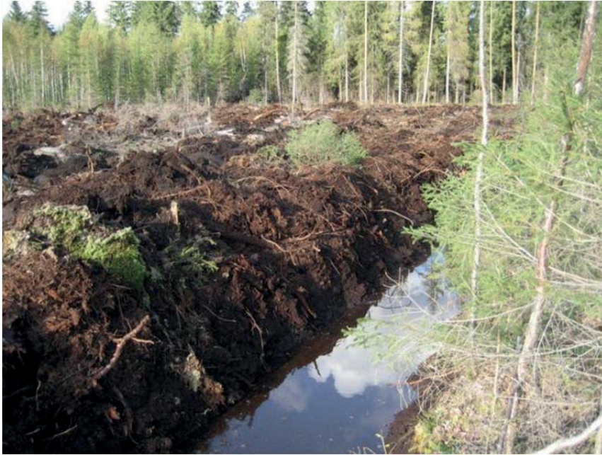
Kuva 29. Ukosuolla toteutettu kunnostusojitus ja maanmuokkaus.
