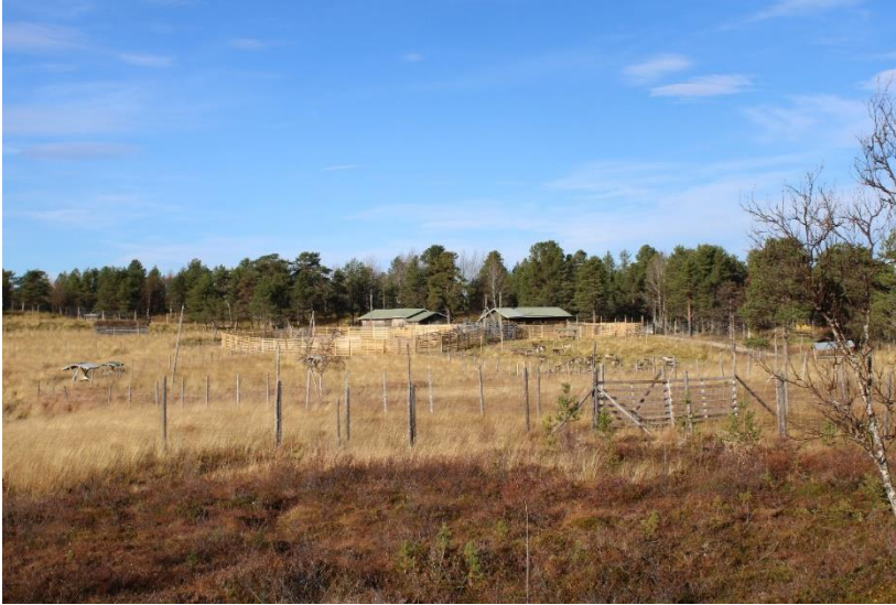
Kuva 5. Koeporotarhan aitalohkoja porojen tarharuokintakokeita varten. Taustalla näkyvät rakennukset ovat porojen käsittelyrakennus oikealla ja rehuvarasto vasemmalla. Oikeassa reunassa oleva tie johtaa toimisto- ja majoitusrakennuksille. Kuva: Luke/Katariina Manni.
