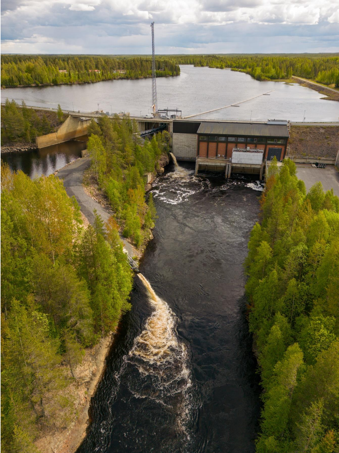
Kuva 2. Ijoen Haapakosken alasvaellusratkaisu kuvattuna alavirran suunnasta. Voimalaitoksen yläkanavassa kelluva ohjaisaita ja alapuolella alasvaellusputki, jonka uloskäynti sijaitsee turbiinipyörteiden alapuolella. Kuva: Jari Lindeman, Luke.
