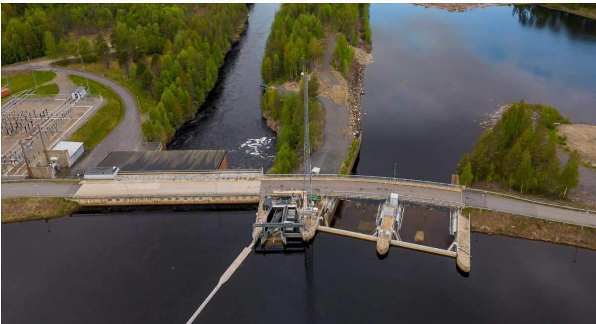
Kuva 1. Iijoen Haapakosken alasvaellusväylän sisäänkäyntialue ylävirrasta kuvattuna. Ohjausaita ohjaa kalat kohti sisäänkäyntisuppiloa (kuvassa keskellä), josta kalat ohjataan alasvaellusväylään tai vaihtoehtoisesti kiinniottohäkkeihin (kuvassa suppilon vieressä oikealla). Kuvassa alasvaellusväylän sisäänkäynnin vasemmalla puolella voimalaitosrakennus ja oikealla puolella säännöstelyluukut (2 kpl). Kuva: Jari Lindeman, Luke.
