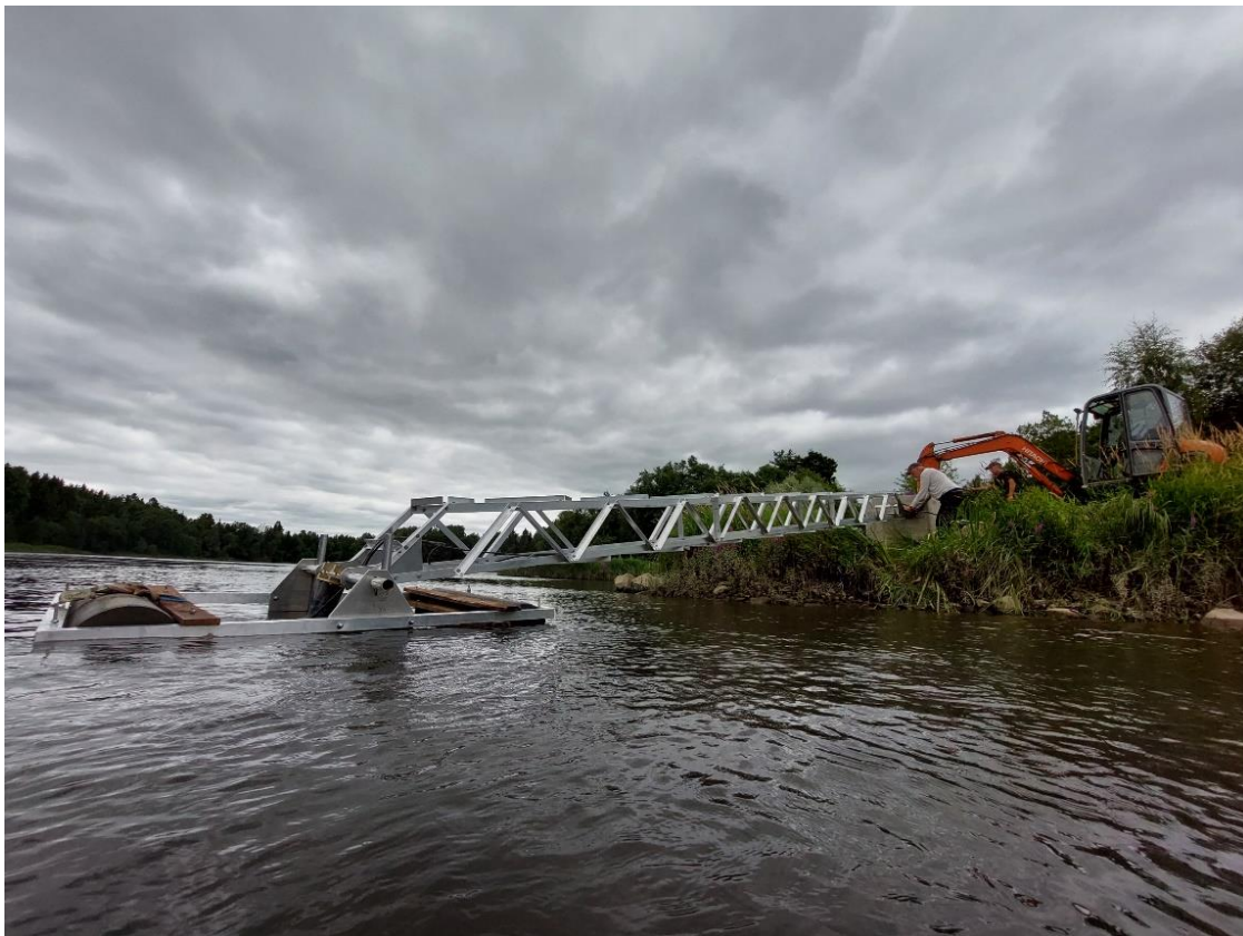
Kuva 1. Kokemäenjoen kelluvan luotaintelineen asennus.
