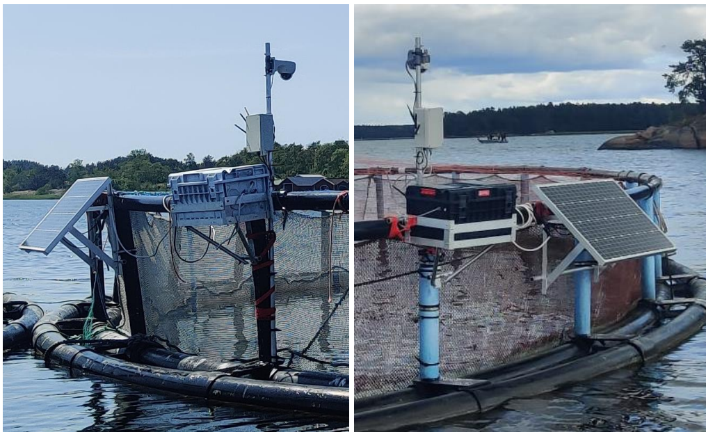
Kuva 5.3. Valvontakamerajärjestelmä asennettuna tutkimuskohteeseen.
