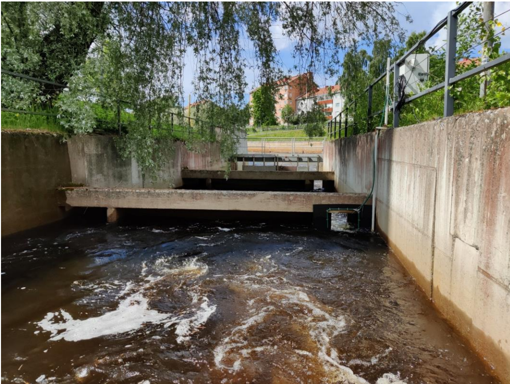
Kuva 30. Merikosken alakalatieen alimmainen PIT-lukuasema. Lukuasema sijaitsee kalatieen kolmanneksi alimmassa pystyraossa, vajaat 10 m alakanavasta ylävirtaan. Tämä lukuasema tuotti havainnot käytännössä samoista PIT-merkityistä kaloista kuin alakanavan pohjoisrannan PIT-lukuasema. Kuva: Panu Orell.
