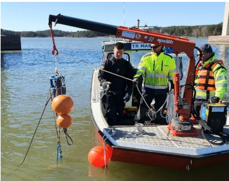
Kuva 10. AceAquatec US3-karkottimen lasku Särkäsalmen pohjalle. Karkotin on yhdistetty painoon, joka pitää sen kiinni pohjassa. Koho puolestaan nostaa karkottimen pystyasentoon. Ankkuriköyden pituudella säädetään karkottimen etäisyys pohjasta. Kuva Esa Lehtonen (Luke)
