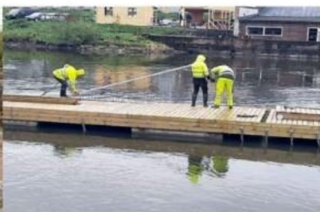
Billnäsin kalatie Mustionjoella, ja vaelluspaikasia ohjaavan aidan rakennustyö meneillään voimalaitoksen yläpuolella.
