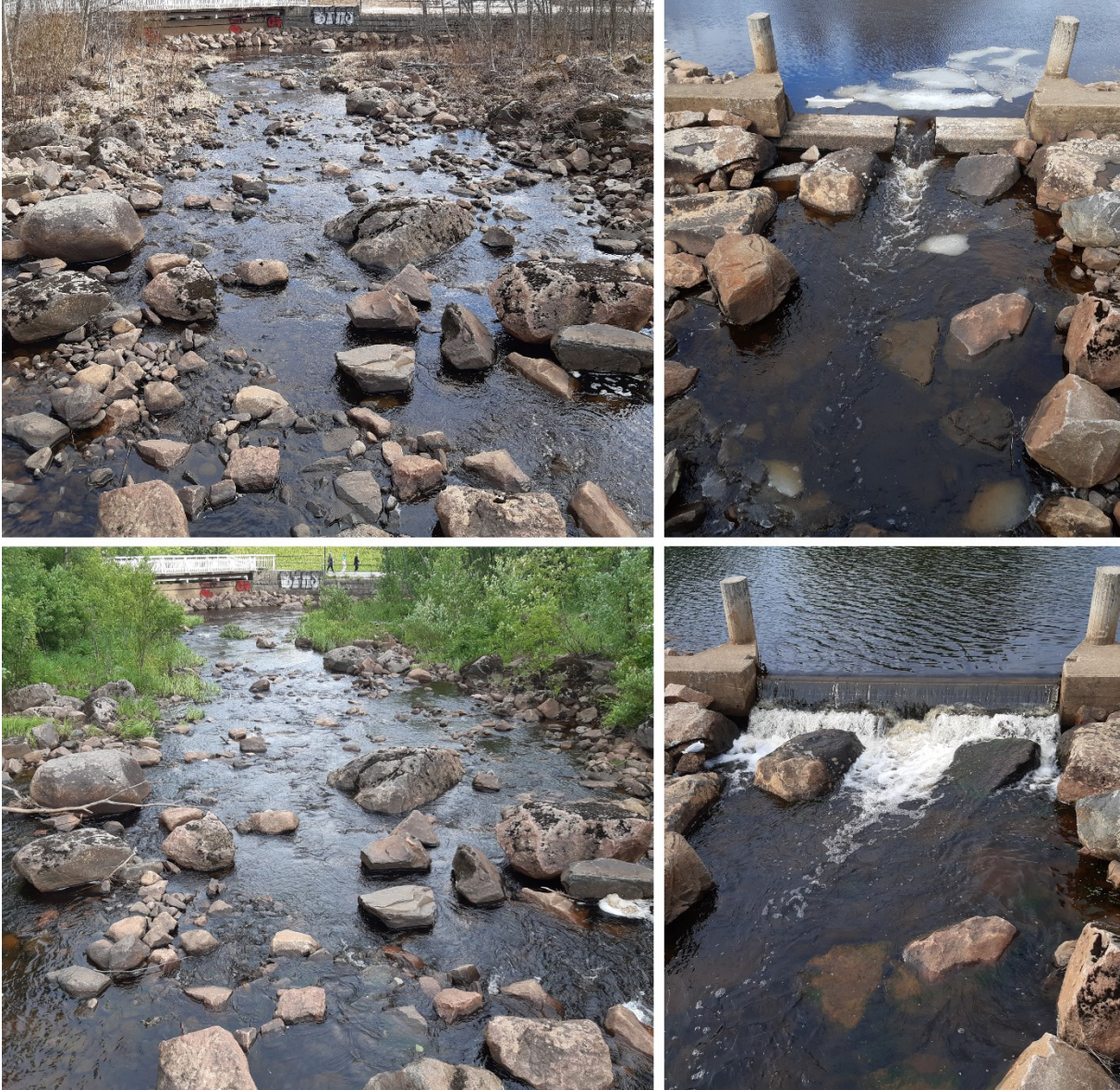
Kuva 21. Linnansaaren ja Plaatansaaren välissä virtaa kaksi samantyyppistä Pokkisenväylän uomaa, joista kuvissa esitettyä itäisemmän uoman alaosa (vasemmalla) ja yläosa (oikealla). Kevättalvella uoman yläosan kynnys on matala, mutta alkukesästä asennettava lisäkynnys vedenkorkeuden nostamiseksi hankaloittaa vähäisellä vesityksellä nousua etenkin uintikyvyltään heikompien kalojen osalta. Vesitystä lisäämällä, uoman keskiosaa ruoppaamalla ja yläosaa porrastamalla kalojen nousumahdollisuudet voisivat parantua. Ylemmät kuvat on otettu 26.4.2022, alemmat 15.6.2022. Kuvat: Riku Rinnevalli, Luke.
