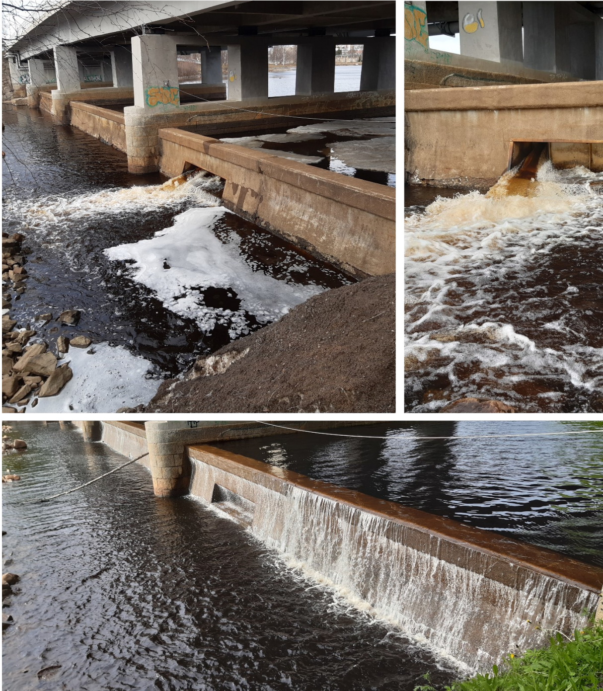
Kuva 20. Ämmänväylän kynnyspato sekä veden juoksutusreitti. Näiden korvaaminen ja/tai porrastaminen matalammilla kynnyspadoilla voisi parantaa kalojen nousumahdollisuuksia ohijuoksutusten aikana. Myös jatkuvasti vesitetyn nousureitin lisääminen kaloille esimerkiksi nykyisen juoksutusreitit yhteyteen voisi mahdollistaa kalojen nousun myös ohijuoksutusten ulkopuolella (Kauneusaltaan alapuoleisen altaan ollessa vesitettyinä). Ylemmät kuvat on otettu 26.4.2022, alemmat 15.6.2022. Kuvat: Riku Rinnevali, Luke.
