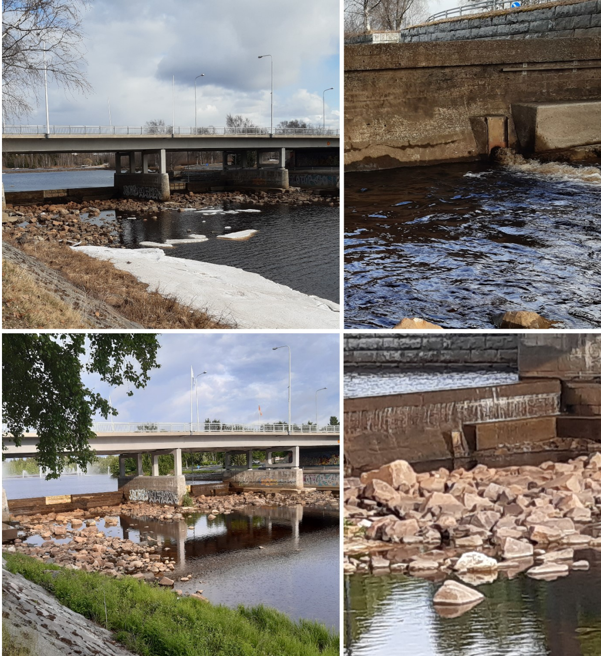
Kuva 19. Tuiranväylän kynnyspato sekä veden juoksutusreitti. Näiden korvaaminen ja/tai porrastaminen matalammilla kynnyspadoilla voisi parantaa kalojen nousumahdollisuuksia ohijuoksutusten aikana. Myös jatkuvasti vesitetyn nousureitin lisääminen kaloille esimerkiksi nykyisen juoksutusreitint yhteyteen voisi mahdollistaa kalojen nousun myös ohijuoksutusten ulkopuolella (Kauneusaltaan alapuoleisen altaan ollessa vesitettyinä). Ylemmät kuvat on otettu 26.4.2022, alemmat 15.6.2022. Kuvat: Riku Rinnevali, Luke.
