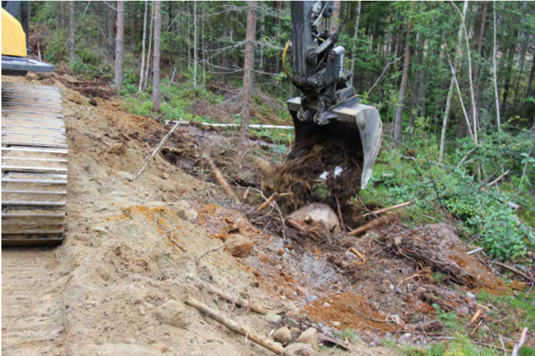
Kuva 37. Kivien asetus sisäluiskaan.
