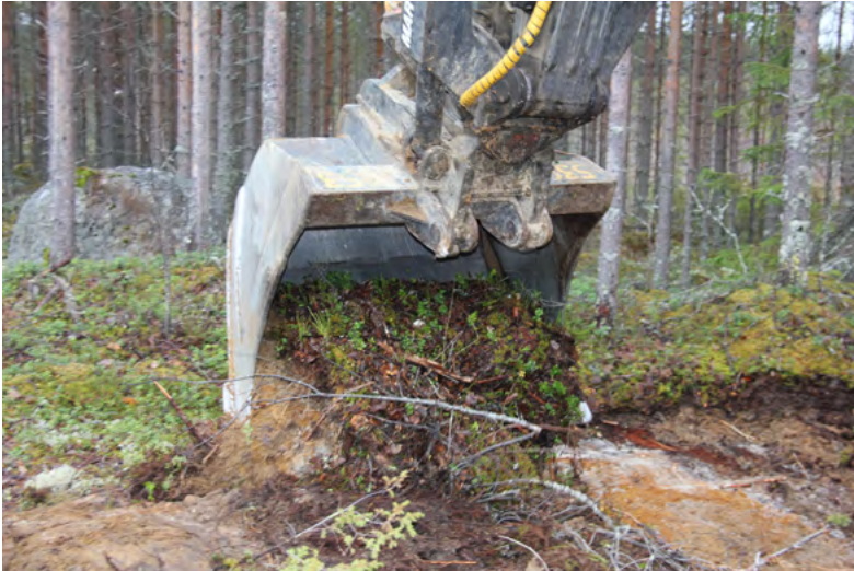
Kuva 14. Pintakerroksen kääntäminen kauhan tyhjennysvaiheessa.
