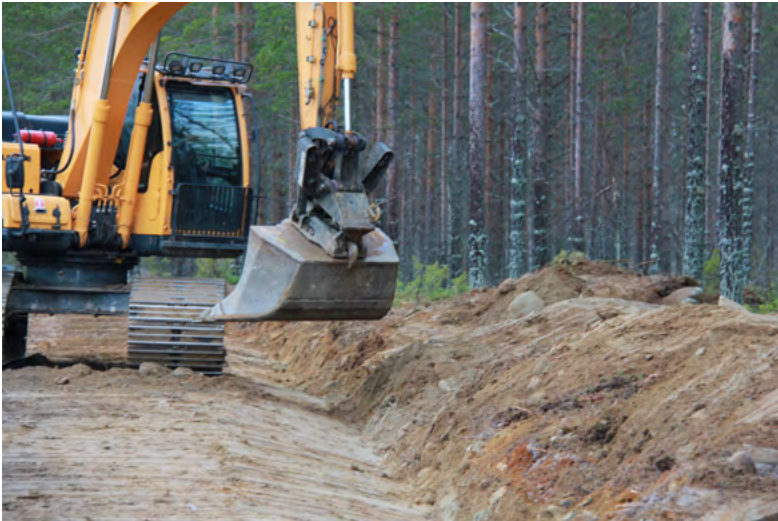
Kuva 43. Viimeistely – tiivistys.
