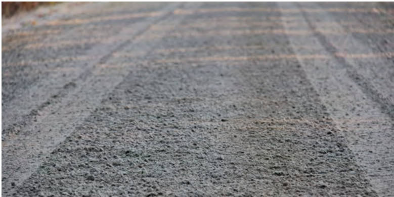
Kuva 56. Pintakerrokset levitetään tierungon kuivumisen jälkeen.
