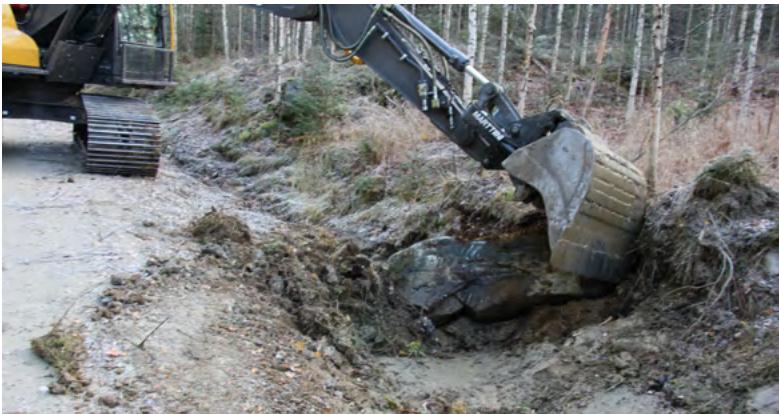
Kuva 3. Maan kaivaminen suurten kivien ympäriltä helpottaa niiden irrottamista.
