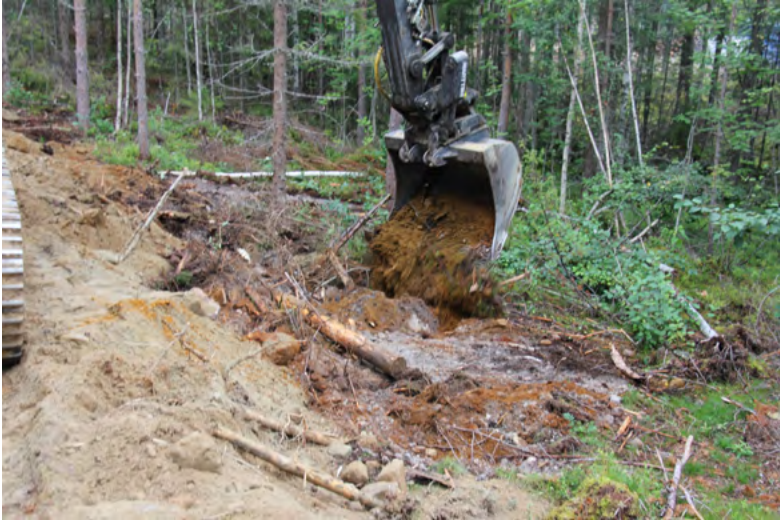
Kuva 38. Peittäminen ja tiivistys.
