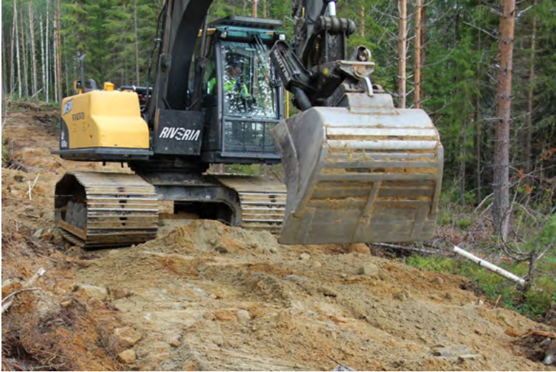
Kuva 39. Ojamaiden levitys, tienpinnan tasaaminen ja sivuttaiskallistukset.
