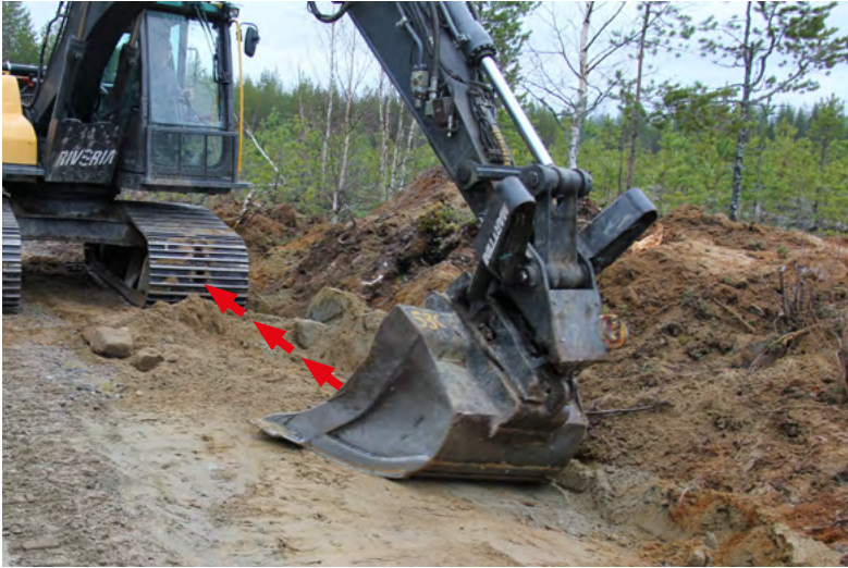
Kuva 23. Sisäluiskan muotoilu kauhan kallistusta hyödyntäen, B.
