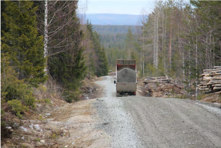
Kuva 1. Suunnittelun tavoitteena on, että vain tien pintakerrokset kuljetetaan kuorma-autolla tiealueen ulkopuolelta.
