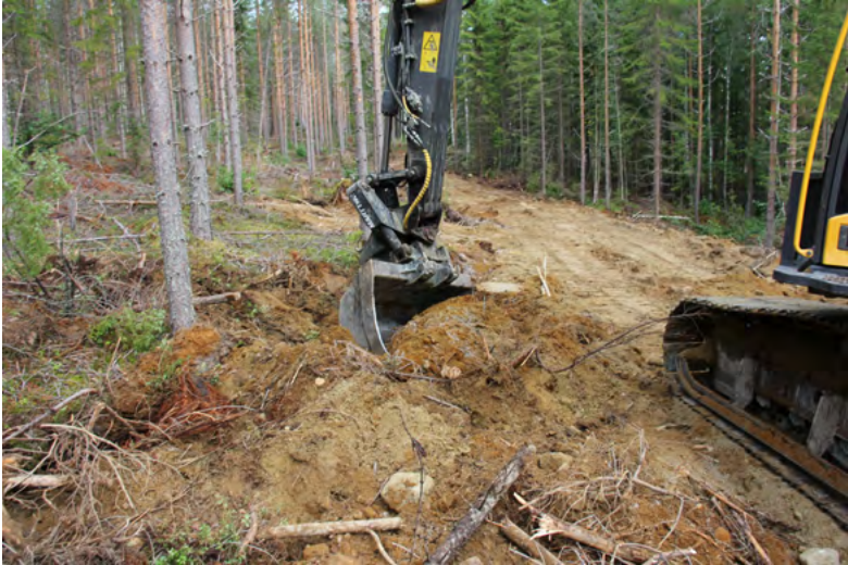
Kuva 17. Ojien kaivaminen ja isojen kivien erottelu.
