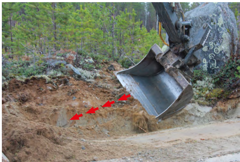
Kuva 19. Ulkoluiskan muotoilu kauhan kallistusta hyödyntäen, A.
