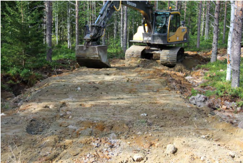
Kuva 40. Tienpinnan tasaaminen ja sivuttaiskallistukset.
