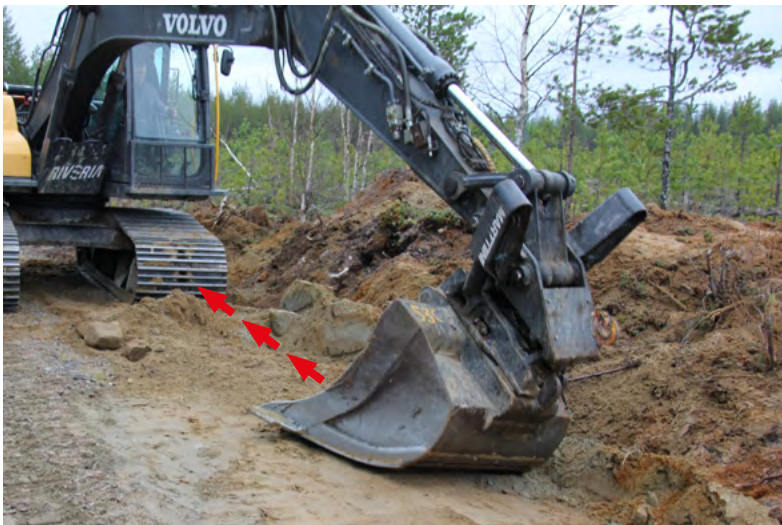
Kuva 22. Sisäluiskan muotoilu kauhan kallistusta hyödyntäen, A.
