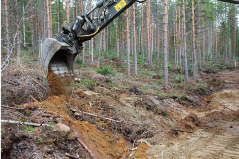
Kuva 29. Maisemointi ulkoluiskaan – peittäminen ja tiivistys.
