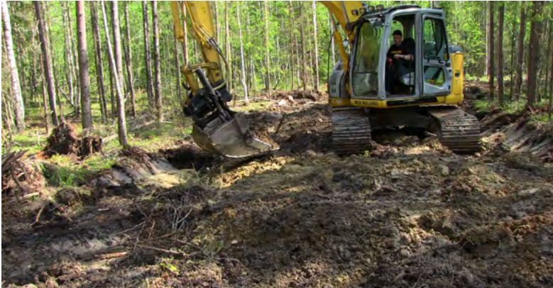
Kuva 2. Koneella työskennellään suunnitelmallisesti ottaen huomioon mm. koneiden vaatimat huoltokuljetukset, jotka voivat aiheuttaa pintavaurioita valmiiksi tehdyllä tienosalla.
