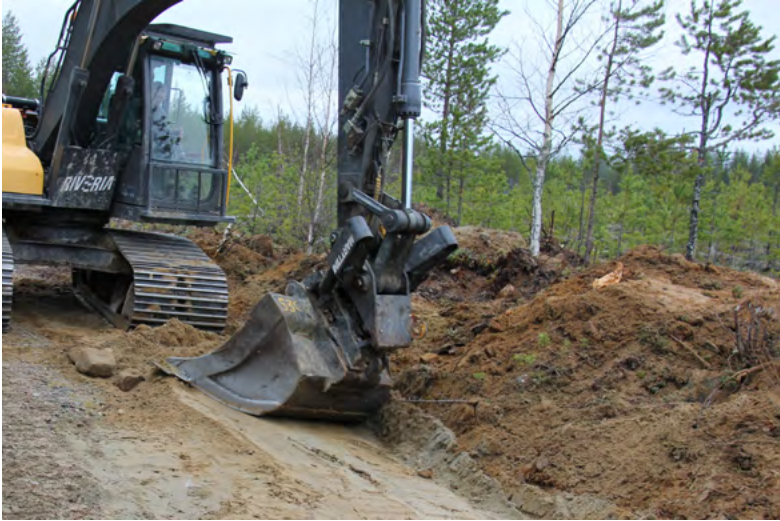
Kuva 25. Sisäluisikan muotoilu kauhan kallistusta hyödyntäen, D.
