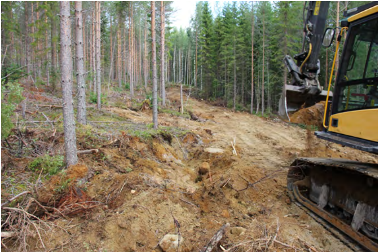
Kuva 18. Maa-aineksen purkaminen tierungon kohdalle.
