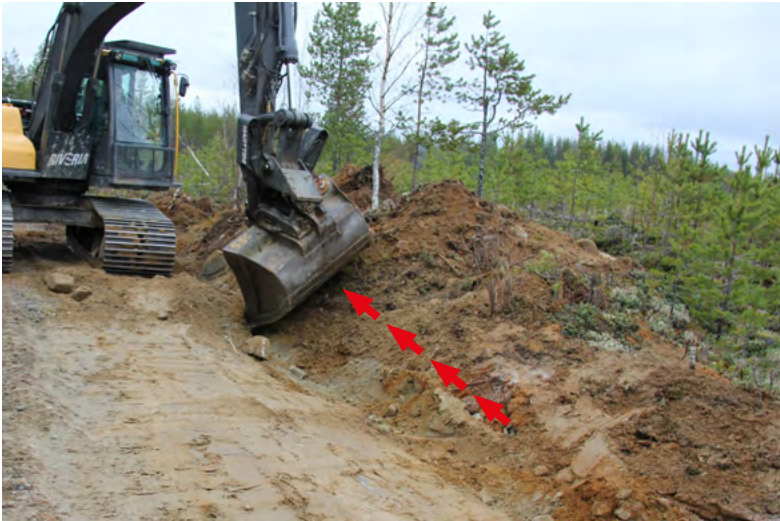
Kuva 21. Ulkoluiskan muotoilu kauhan kallistusta hyödyntäen, C.
