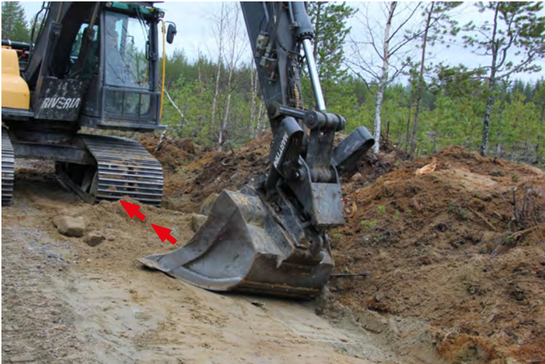
Kuva 24. Sisäluiskan muotoilu kauhan kallistusta hyödyntäen, C.
