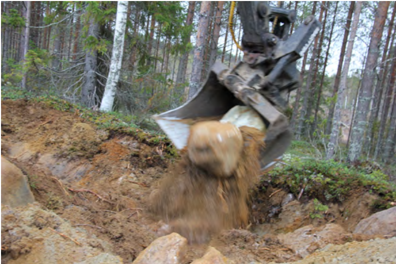
Kuva 32. Kivien siirto maanottoaikkaan.
