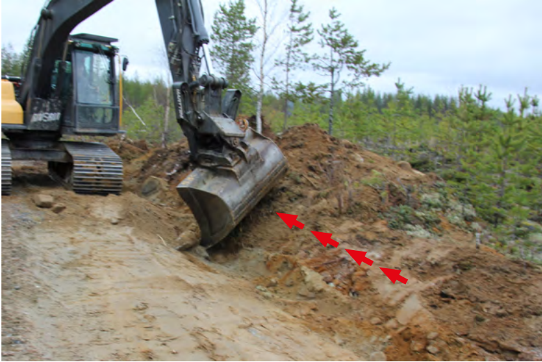
Kuva 20. Ulkoluiskan muotoilu kauhan kallistusta hyödyntäen, B.
