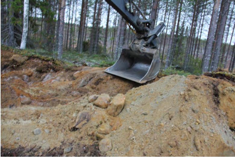
Kuva 33. Maanottopaikan peittäminen ja tiivistys.
