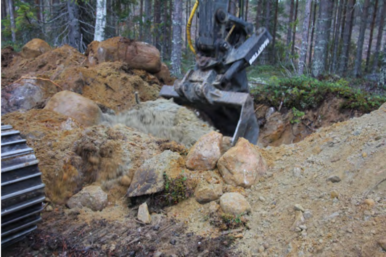
Kuva 31. Maanottoaikan kaivaminen, B.
