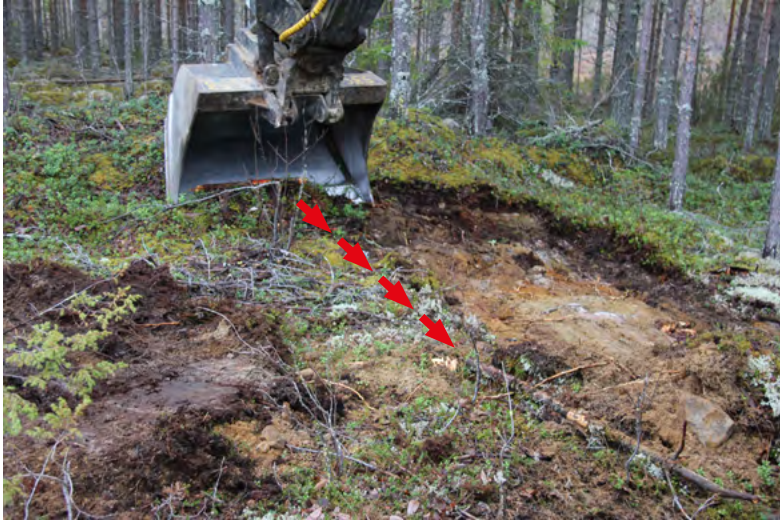
Kuva 11. Aloitus sivuojan kohdalta.
