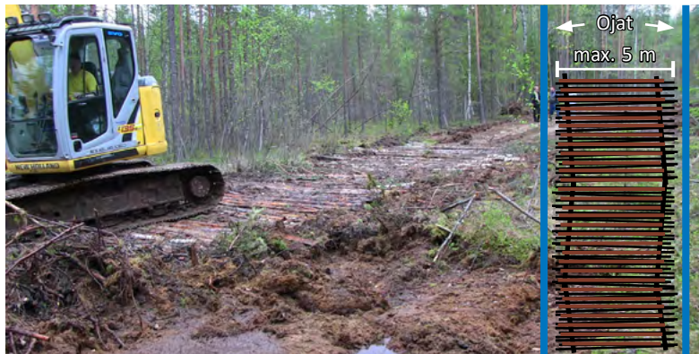
Kuva 44. Telalavan rakenne.
