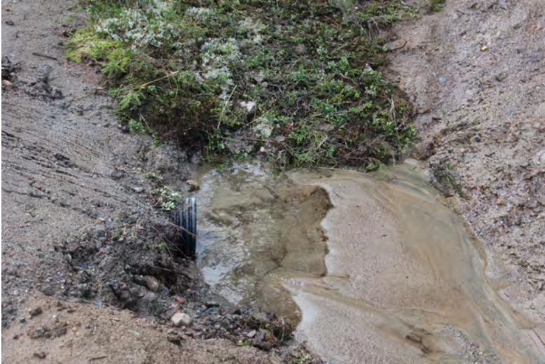
Kuva 61. Vuolaasti virtaavat ojat tuovat kohteelle nopeasti suuriakin vesimääriä. Pienempien putkien asennuksen ajaksi riittää yleensä yläpuolisen ojan patoaminen tai vesien johtaminen sivummalle. Ohutjakoisilla mailla voidaan käyttää mm. pintamaan kunnakerrosta estämään maa-aineksen irtoamista.
