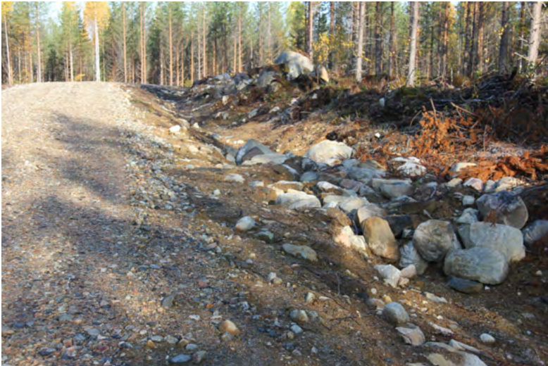
Kuva 51. Metsäliittymän kohdalla ojaa voidaan täyttää esim. kivillä.
