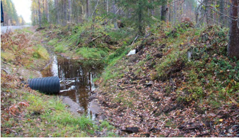
Kuva 53. Oikein mitoitettu ja asennettu rumpu toimii ilman huoltoa vuosikymmeniä.
