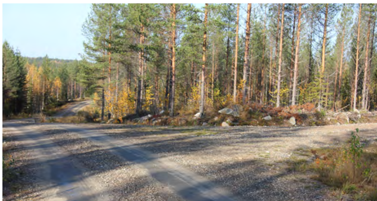
Kuva 50. Tavoitteena on, että metsätien liittymät tehdään T-risteyksellä tasaisille maastonkohdille.
