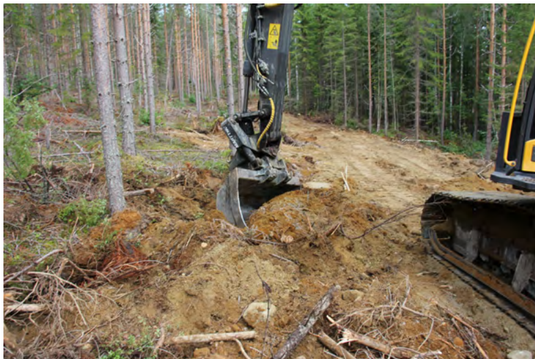
Рисунок 17. Извлечение валунов при строительстве канавы.
