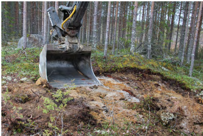
Рисунок 15. И уплотняется с помощью ковша.
