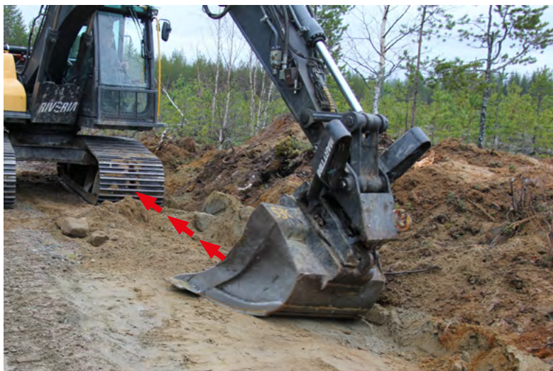
Рисунок 23. Планировка поверхности внутреннего откоса при помощи поворотного ковша. Схема В.
