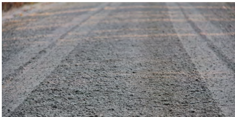
Рисунок 56. Поверхностные слои наносятся после высыхания дорожного каркаса.
