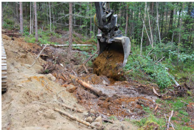
Рисунок 38. Выполнение присыпки и уплотнения грунта.
