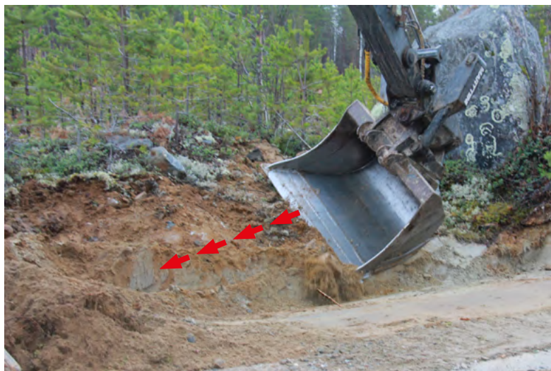
Рисунок 19. Планировка поверхности внешнего откоса при помощи поворотного ковша. Схема А.
