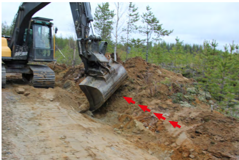
Рисунок 20. Планировка поверхности внешнего откоса при помощи поворотного ковша. Схема В.
