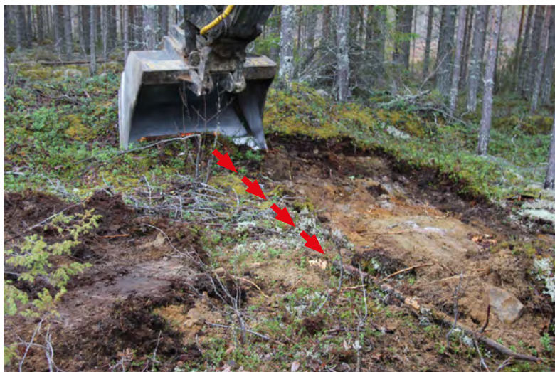
Рисунок 11. Земляные работы начинаются с разработки поверхности, занимаемой боковыми канавами.
