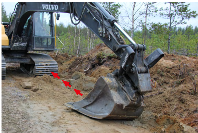
Рисунок 22. Планировка поверхности внутреннего откоса при помощи поворотного ковша. Схема А.
