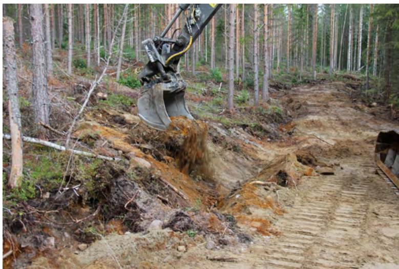
Рисунок 28. Рекультивация внешнего откоса путем выполнения присыпки из слоя грунта. Схема В.
