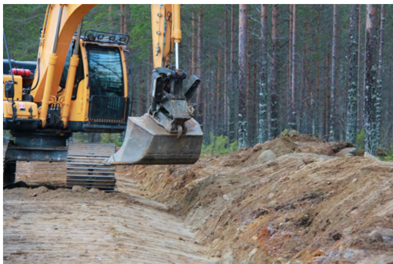
Рисунок 43. Уплотнение поверхности земляного полотна.
