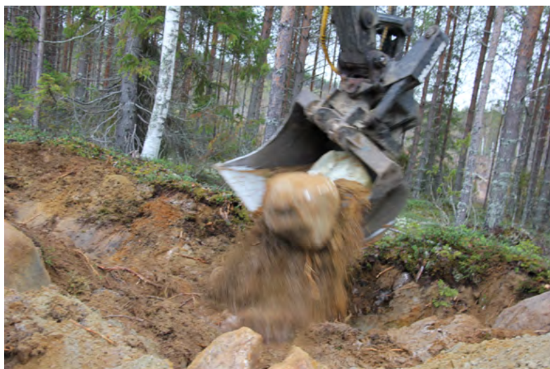
Рисунок 32. Перемещение валуна в резерв.
