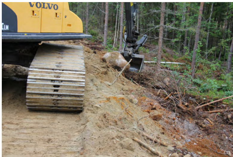
Рисунок 35. Сбор камней ковшом.
