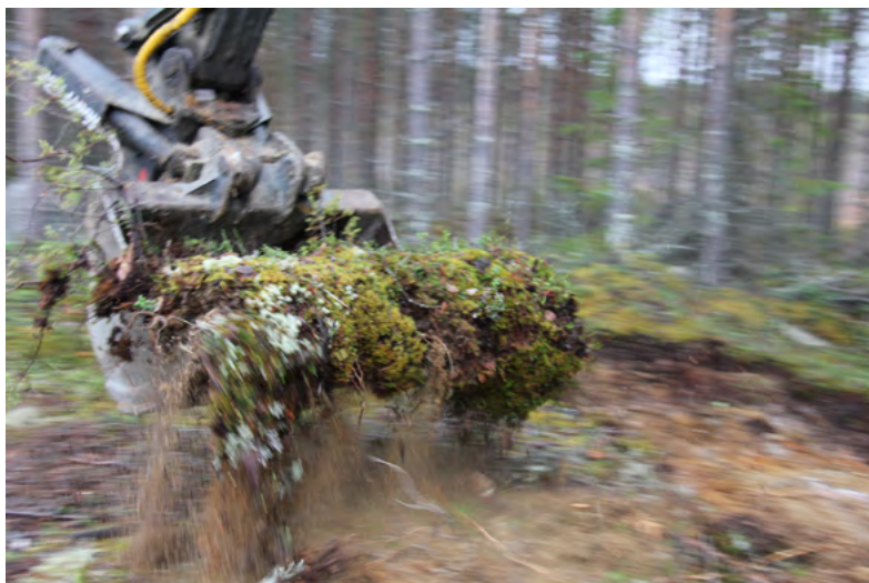
Рисунок 13. Перемещается к основанию земляного полотна.
