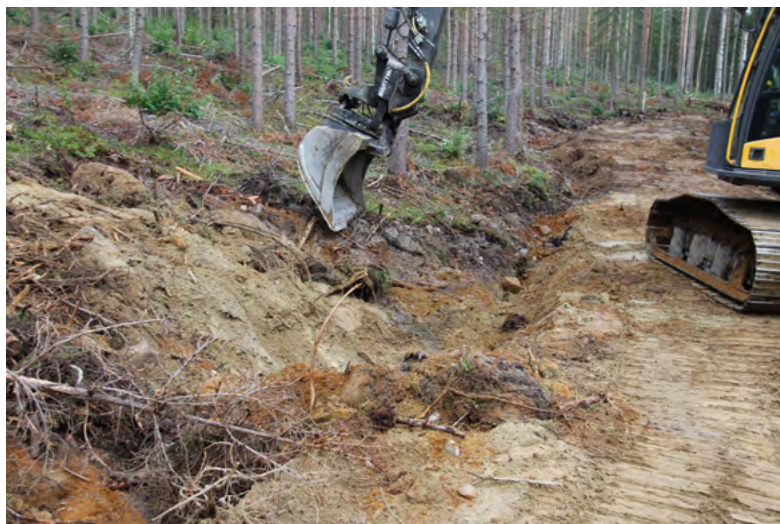
Рисунок 26. Рекультивация внешнего откоса.
