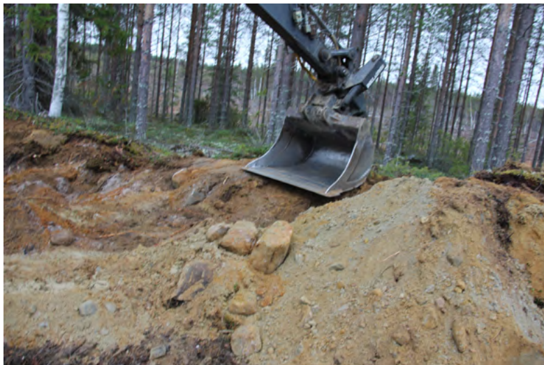
Рисунок 33. Выполнение присыпки и уплотнение грунта в месте разработки резерва.
