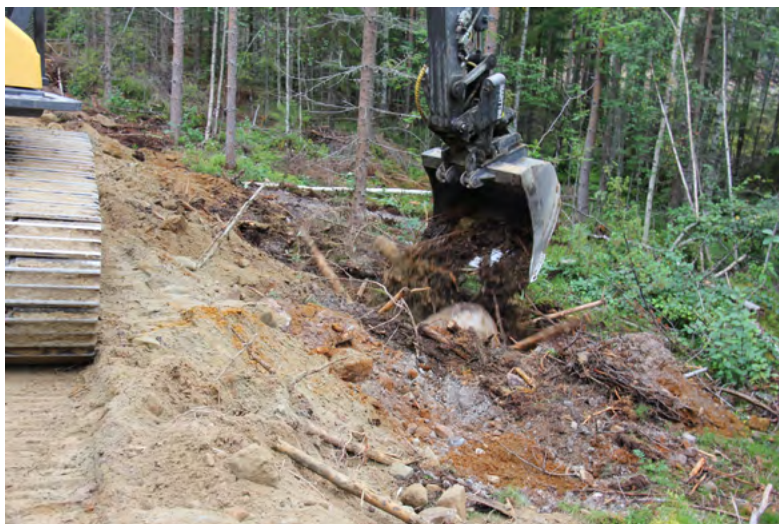
Рисунок 37. Укладка камней в стену внутреннего откоса.
