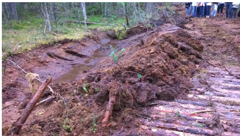
Рисунок 46. Предотвратить гниение древесины возможно, если конструкцию, включая ее края, герметично укрыть.
