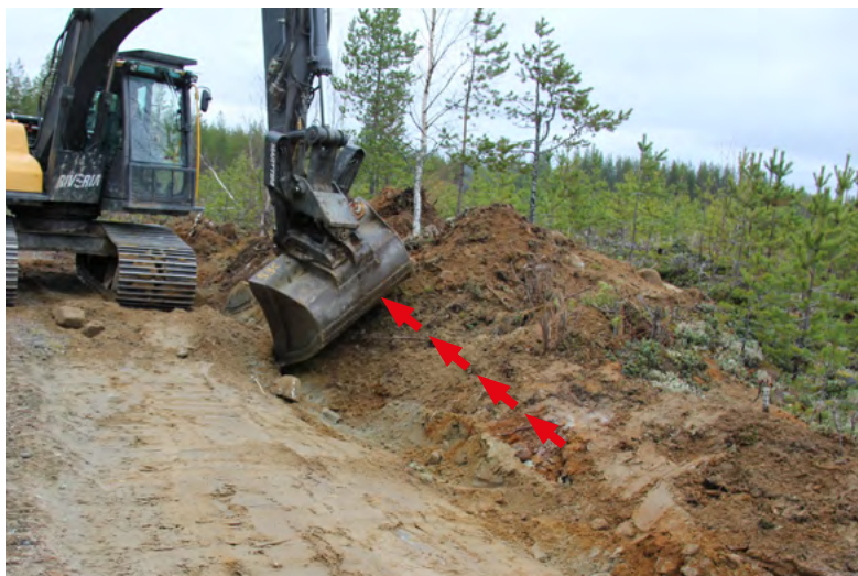
Рисунок 21. Планировка поверхности внешнего откоса при помощи поворотного ковша. Схема С.
