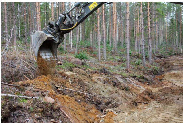
Рисунок 29. Рекультивация внешнего откоса путем выполнения присыпки и уплотнения грунта.
