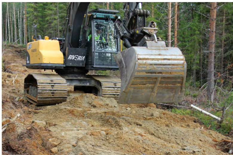
Рисунок 39. Укладка грунта из выемки, выравнивание поверхности основания и откосов.
