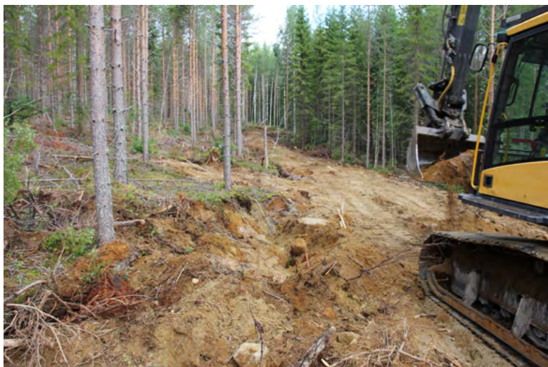
Рисунок 18. Отсыпка грунта в основание земляного полотна.
