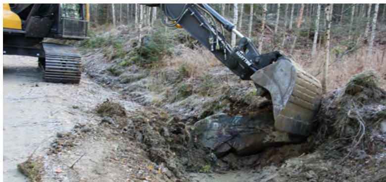
Рисунок 3. Крупный камень легче извлечь из земли, если его предварительно окопать со всех сторон.
