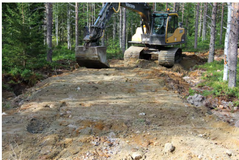
Рисунок 40. Выравнивание грунта с одновременным выполнением планировки откоса.
