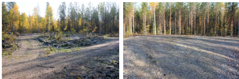
Рисунок 54. Для маневрирования автопоезда требуются большие разворотные площадки.
