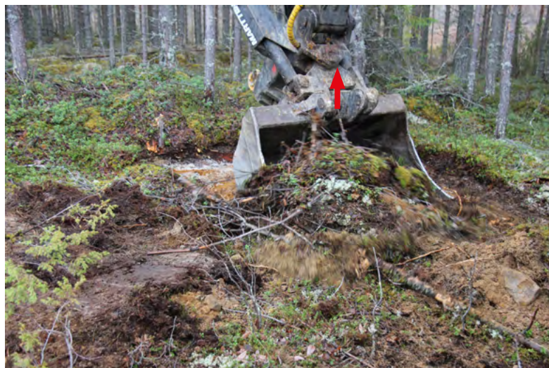
Рисунок 12. Полной шириной ковша срезается плодородный слой почвы.
