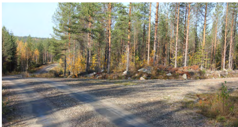
Рисунок 50. Т-образный перекресток - наиболее приемлемая форма перекрестка на ровном участке лесной дороги.
