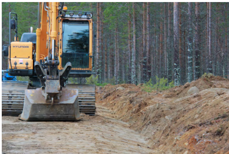
Рисунок 42. Планировка поверхности земляного полотна.
