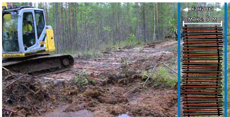
Рисунок 44. Конструкция настила.
