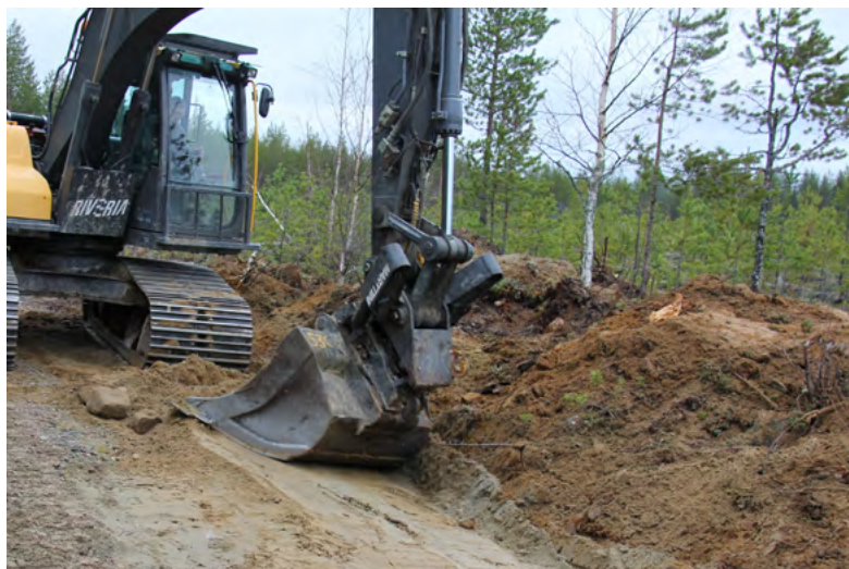
Рисунок 25. Планировка поверхности внутреннего откоса при помощи поворотного ковша. Схема D.
