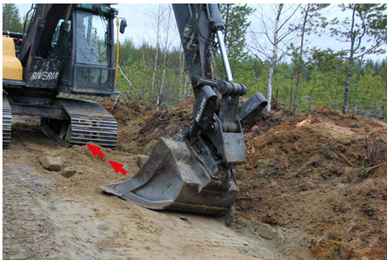
Рисунок 24. Планировка поверхности внутреннего откоса при помощи поворотного ковша. Схема С.
