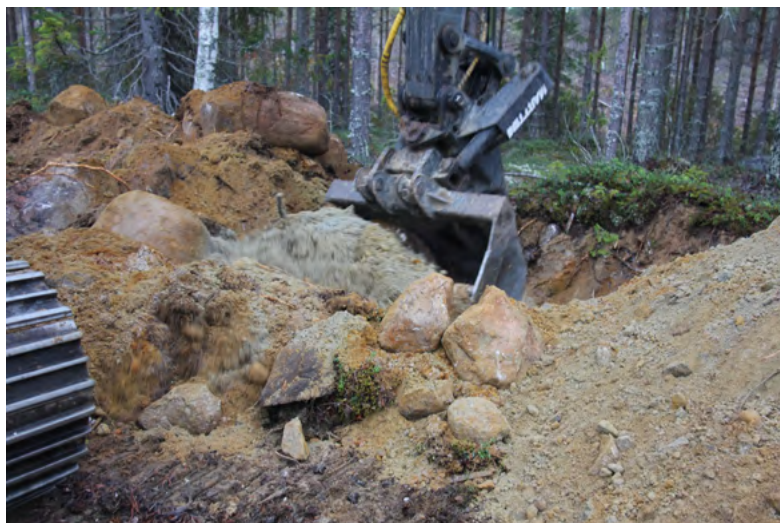
Рисунок 31. Разработка резерва. Схема В.
