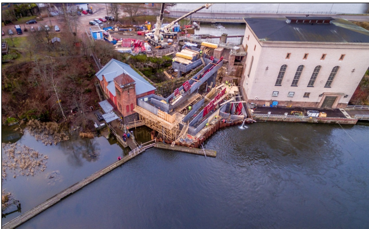
Kuva 8. Korkeakosken kalatie Kymijoen rakentumassa syksyllä 2015. Kuva: Pia Nordström, Raaseporin kaupunki.
