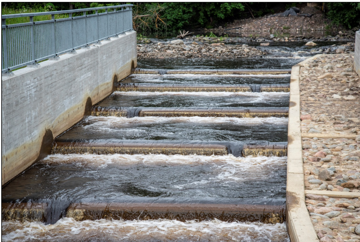
Kuva 9. Villamon padon vanhat patorakenteet purettiin. Betonikanavaa luonnonmukaistettiin ja mahdollistettiin kalan nousu kynnyksillä ja kiveämällä. Kuva: Jari Ilmonen.
