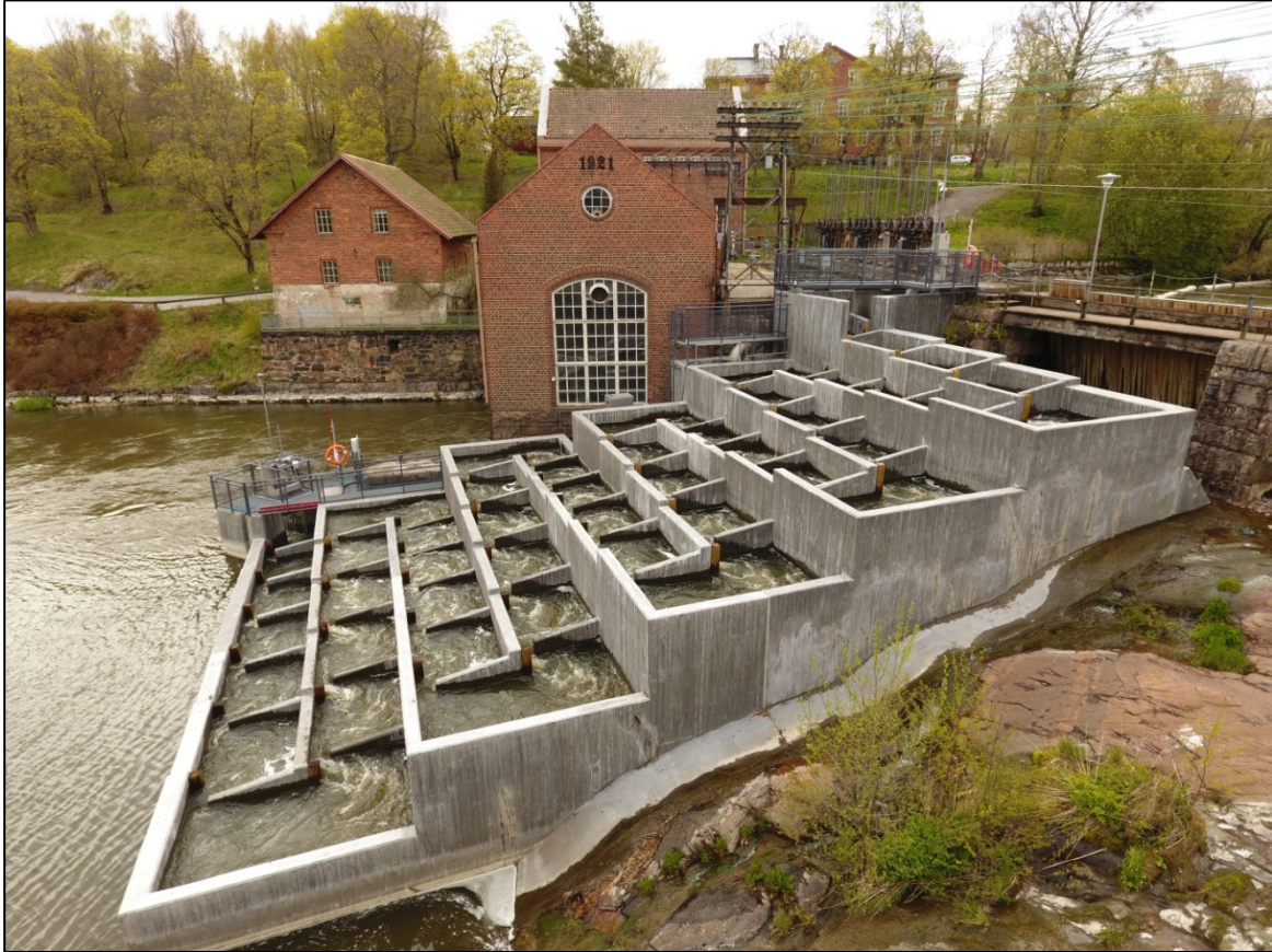
Kuva 4. Billnäsin teknisen kalateiden betonirakenteiden pintakäsittely tehtiin Museoviraston lausunnon mukaisesti vastaamaan ympäröivän teollisuusympäristön robustia luonnetta. Kuva: Pia Nordström, Raaseporin kaupunki.
