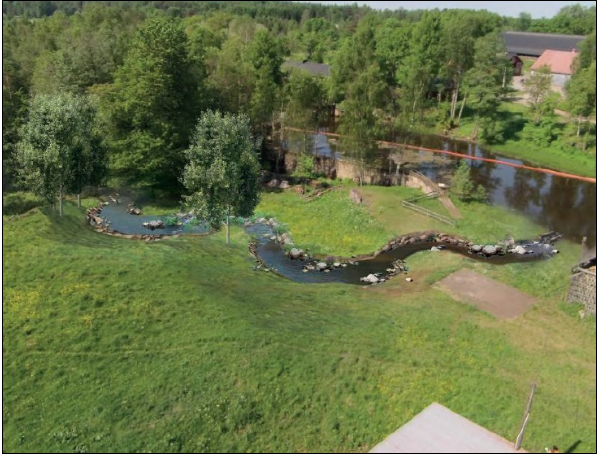
Kuva 6. Havainnekuva Kiskonjoen Kiskon luonnonmukaisen kalatien yläosasta. Kuva: Arkkitehti- ja maisemasuunnittelu Nyman & Ristimäki.
