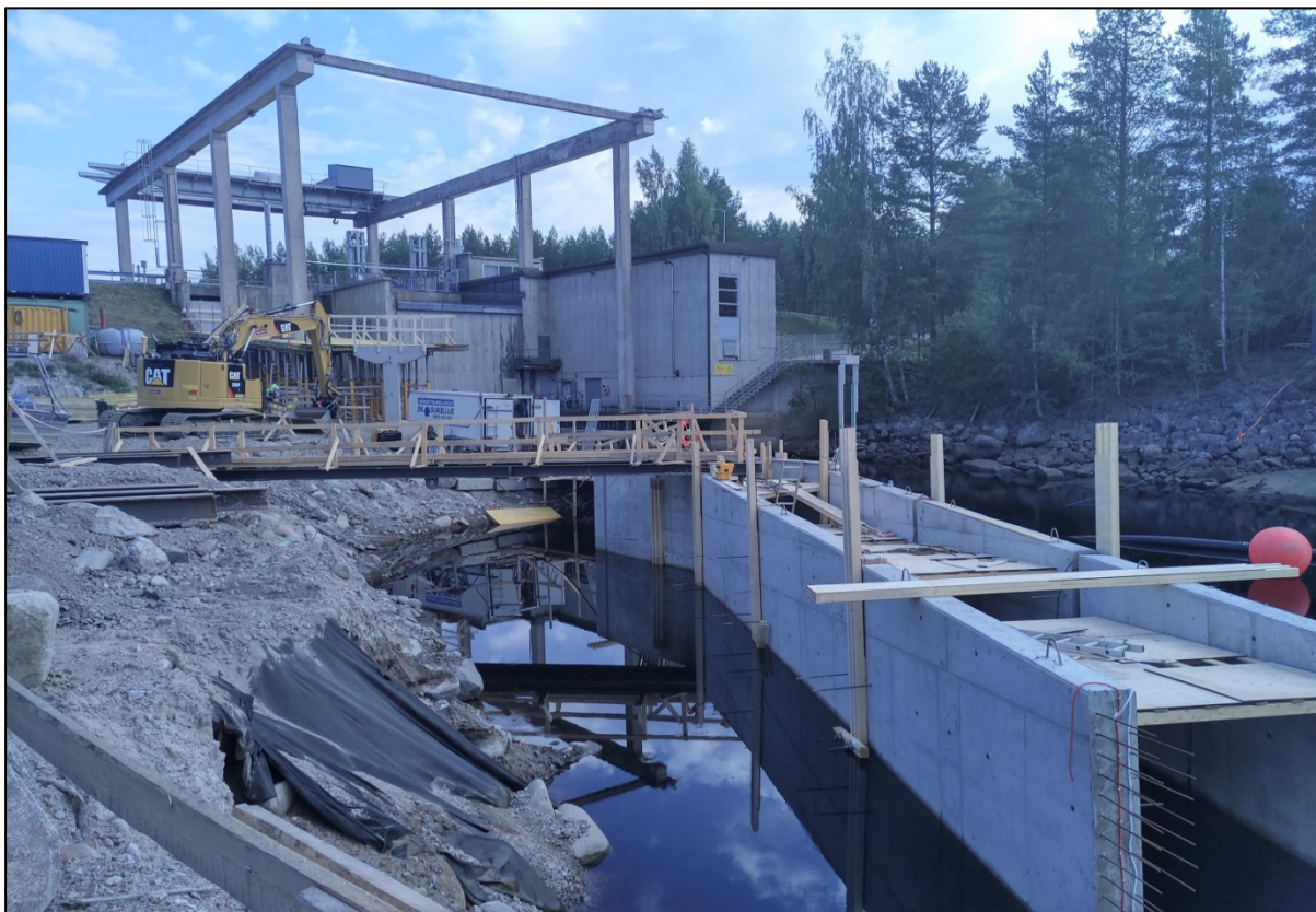
Kuva 7. Leuhunkosken kalatie on rakenteilla Saarijärven reitillä elokuussa 2020. Kuva: Teemu Sarnola, Vattenfall.
