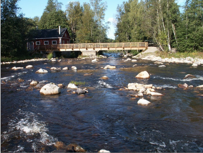
Kuva 10. Läsäkosken alue taimenen vaellusesteenä toimineen patorakenteen poistamisen ja alueen kunnostamisen jälkeen. Kuva: Jukka Syrjänen.
