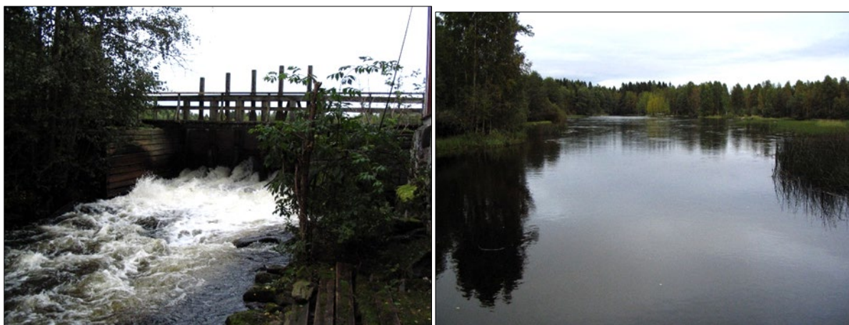
Kuva 9. Läsäkosken pato (vasemmalla) ja sen yläpuolinen suvanto (oikealla) ennen alueen kunnostamista. Kuvat: Jukka Syrjänen.
