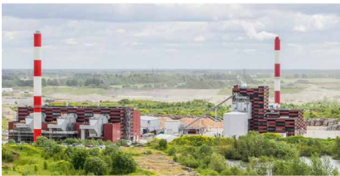
1 nuotrauka. AS Utilitas Talino kogeneracinių elektrinių vaizdas iš išorės A
